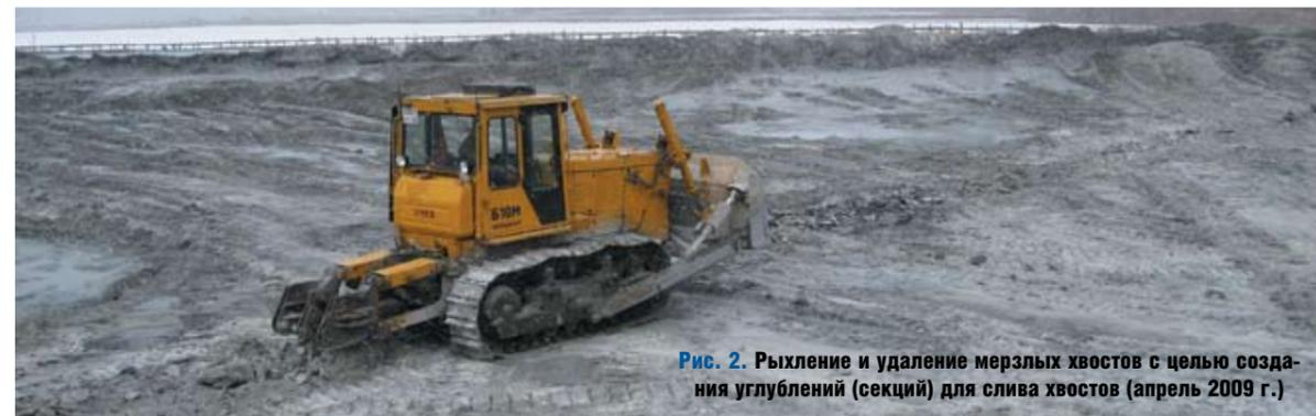
**Рис. 2. Рыхление и удаление мерзлых хвостов с целью создания углублений (секций) для слива хвостов (апрель 2009 г.)**
