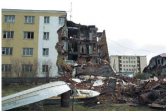
**Фото 1.** Разрушение жилого дома в результате деградации мерзлоты в основании здания
