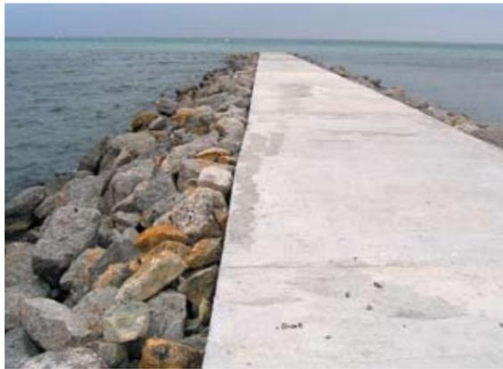
Рис. 3. Бетонная плита поверх каменноталросной буны
