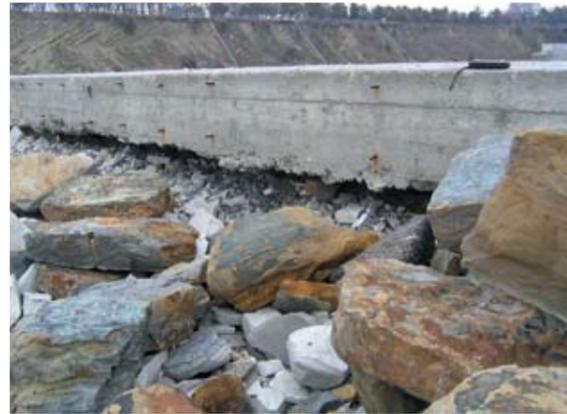
Рис. 4. Подмыв под бетонной плитой
