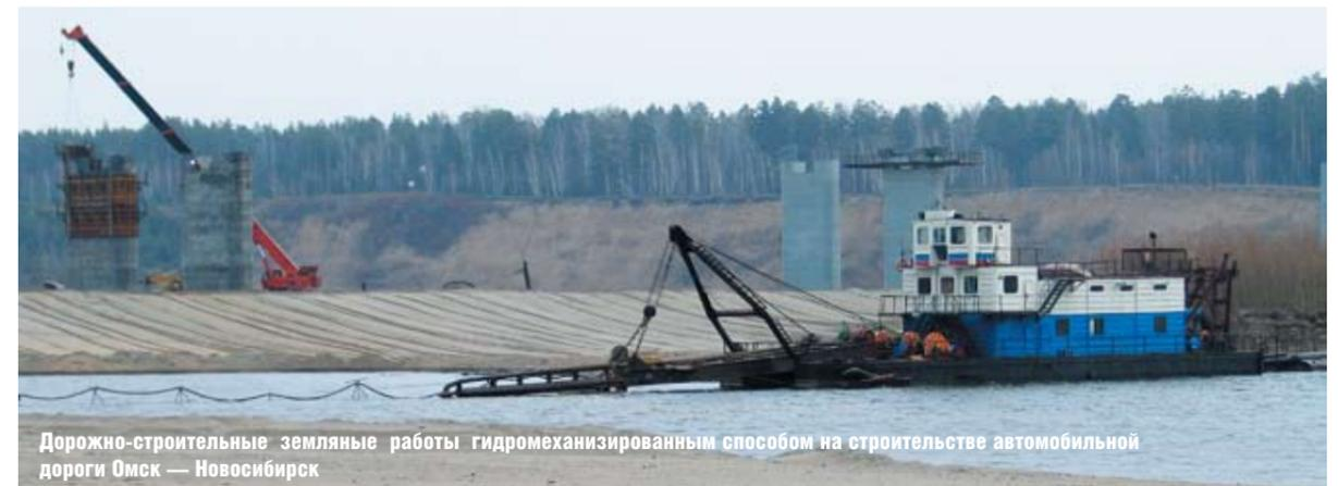
Дорожно-строительные земляные работы гидромеханизированным способом на строительстве автомобильной дороги Омск — Новосибирск
