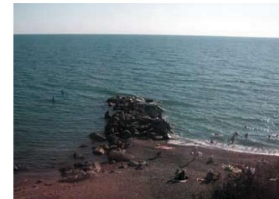
**Рис. 2.** Недавно построенная, но уже полуразрушенная каменнонабросная бунна
