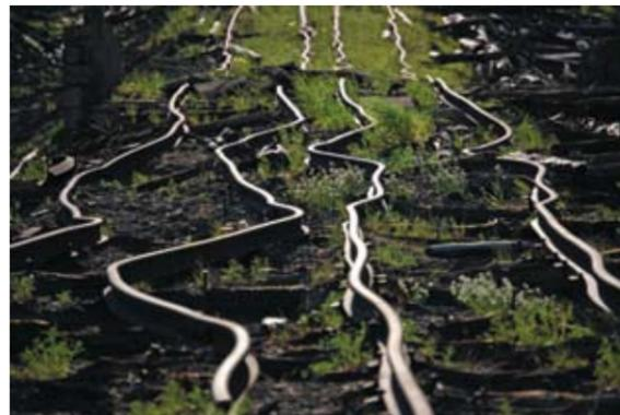
**Фото 2.** Таяние мерзлоты приводит к деформации железнодорожных путей
