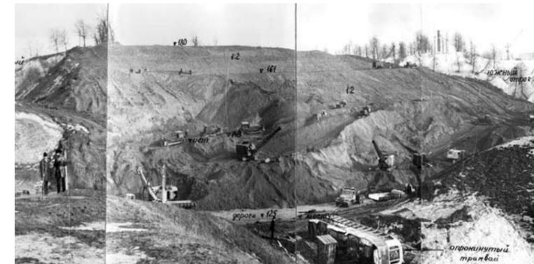
Там же. Работы по выемке оползших грунтов и улоаживание склона. На переднем плане — опрокинутый оползнем трамвай
