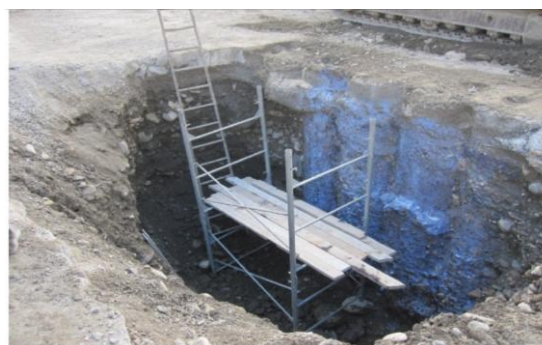
Рисунок 16. Схема расположения свай и контрольных скважин на опытном полигоне (план на отм. 626,8 м) Рисунок 17. Шурф фрагмента 1: видна поверхность свай
