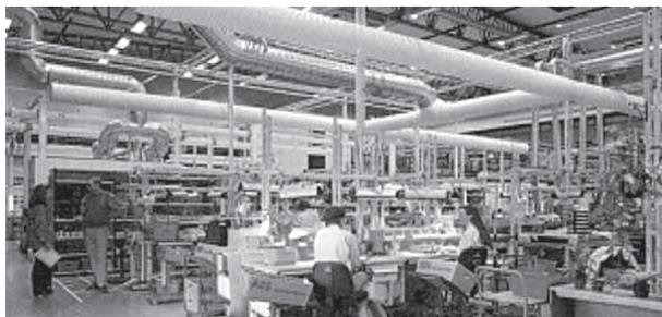
Рис. 4. Активная термовытесняющая вентиляция
