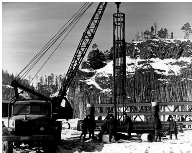
Рис. 3. Работы на льду р. Ангары по монтажу свайных опор моста
