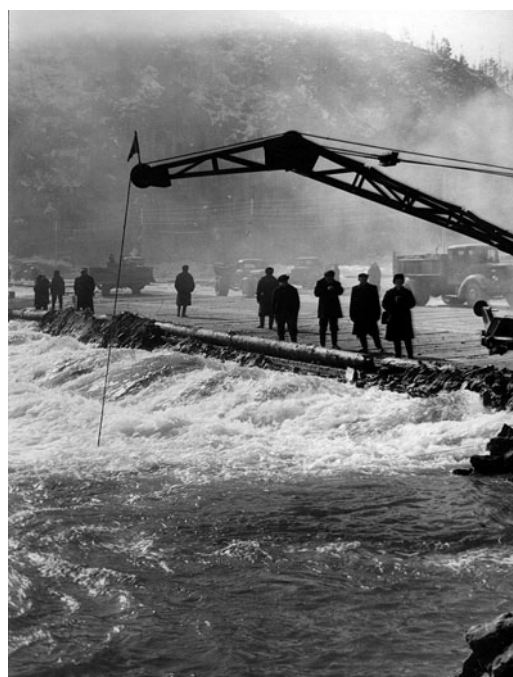
Рис. 1. Завершающий этап отсыпки банкета 30 марта 1957 г. Видна кромка льда с настилом и колесоотбоем
