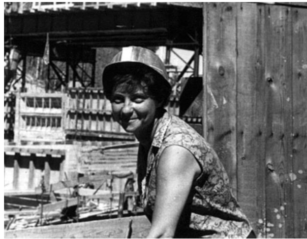
Строитель Усть-Илимской ГЭС
