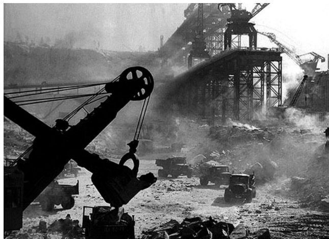
Перекрытие р. Ангары
