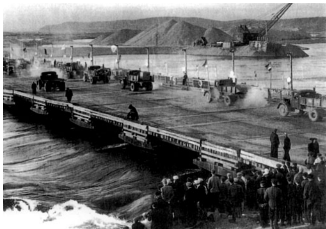
Перекрытие реки Ангары
