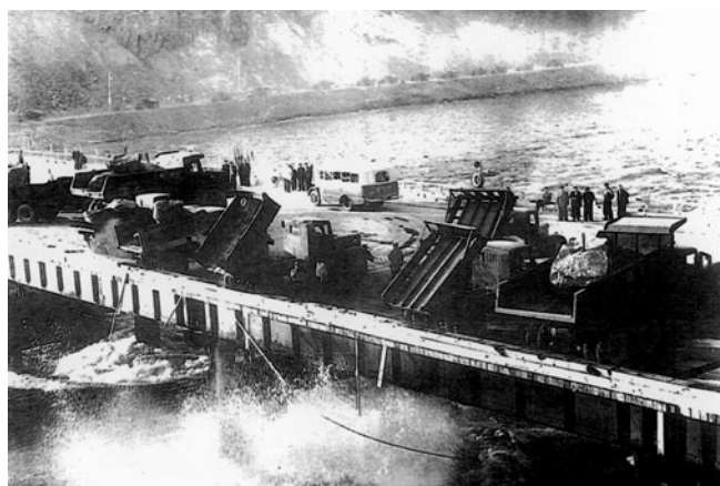
Братскгэсстрой перекрыл Ангару
