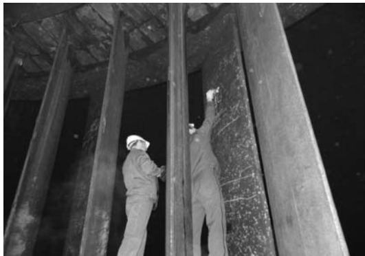
Рис. 3. Работа бригады экспертов на колоннах статора гидротурбины
