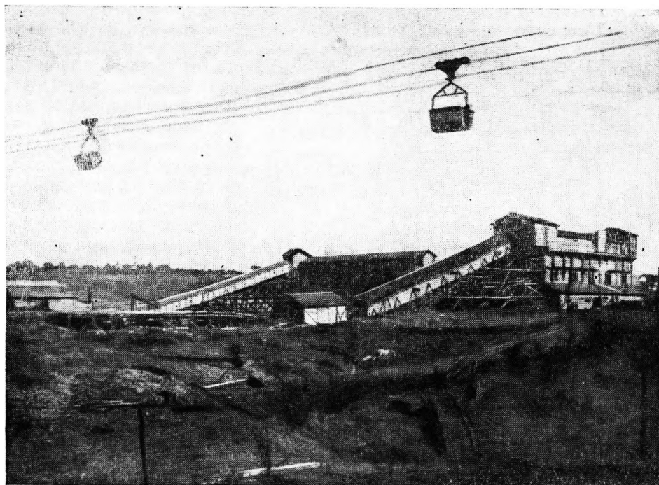
Фиг. 92. Наклонные эстакады бетонного комбината шлюза № 5
