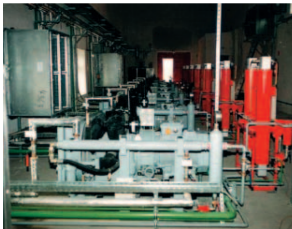
Азербайджан: трехступенчатые компрессоры Sauer (модель WP270L) и адсорбционные осушители сжатого воздуха Zander
