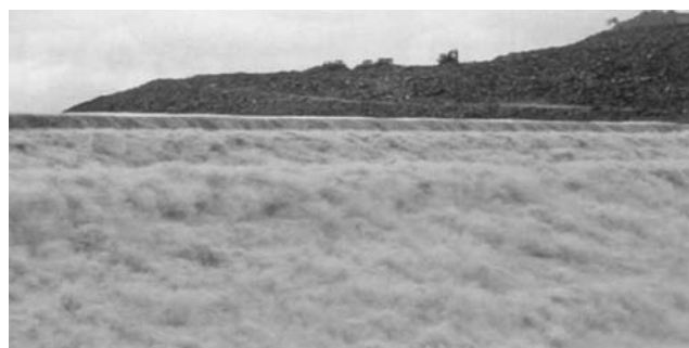
Рис. 5. Начальный этап пропуска паводка 2007 г. через недостроенную плотину Куадат
