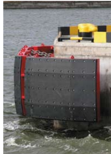
Фото 4. Вариант защиты угла причала
