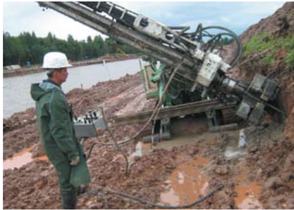
Рис. 2. Устройство опытного анкера в глине
