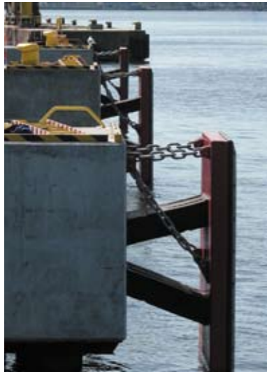
Фото 2. Отбойные устройства с металлическим каркасом
