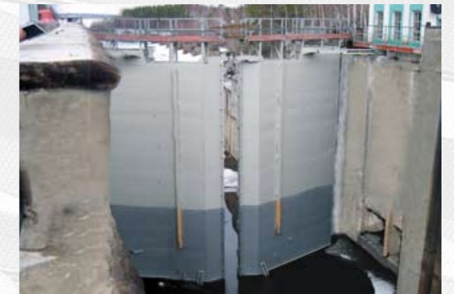
Шлюз Беломорканала (Россия). Антикоррозионная защита ворот. Системы покрытий: надводная часть — Sika Permacor 2004 (грунтовка) + Sika Permacor 2330 (покрывной материал), надводная часть Sika Epiter TF130.
