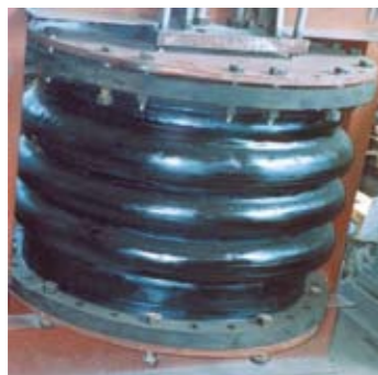
Рис. 6. Компенсатор радиальный
