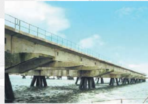
Платформа для перегрузочных работ Voslapper Groden (Германия). Антикоррозионное покрытие 510 стальных труб-свай. Система покрытия: Sika Epiter TF130.
