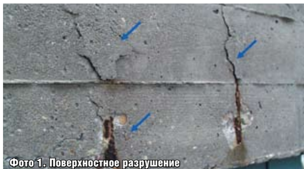
Фото 1. Поверхностное разрушение
