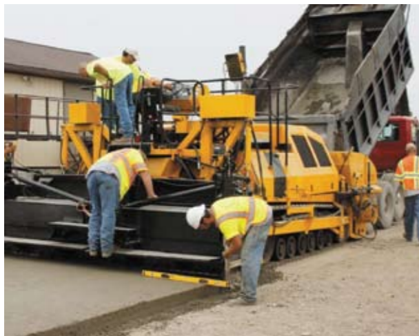
Рис. 2. Бетоноукладчик фирмы Gomaso
