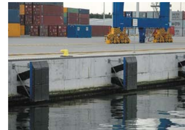
Фото 1. Типичная конструкция рамы отбойного устройства с боковым и верхним скошенным краем
