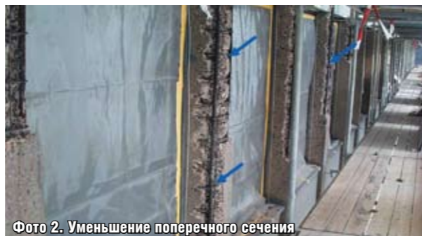
Фото 2. Уменьшение поперечного сечения
