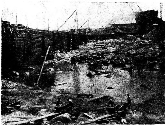
Фиг. 21. Общий вид котлована среднего потока после откачки.
