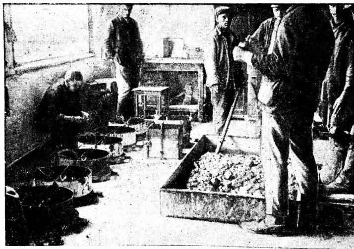
Фиг. 18. Приготовление бетона. Слева формы для образцов.
