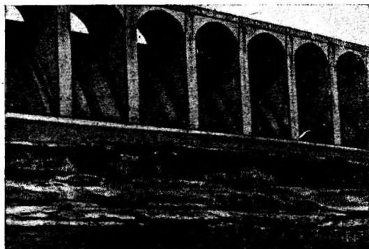
Фиг. 167. Размывы основания плотины Вильсон.
