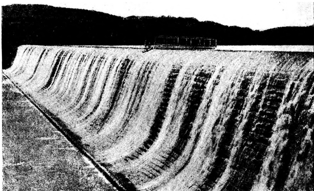
Фиг. 148. Каменная плотина Аустин (США) (разрушилась в 1900 г.).
