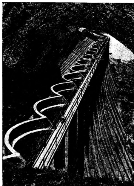
Фиг. 154. Многоарочная железобетонная плотина Пальмдейл (Palmdale) (США).
