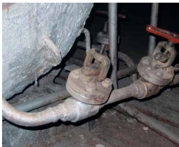
Задвижка компактная стальная с сорванной резьбой на штоке
