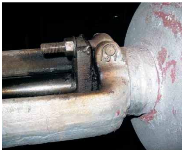
Сальниковый узел задвижки Ду300, Ру40 с полностью затянутой сальниковой муфтой
