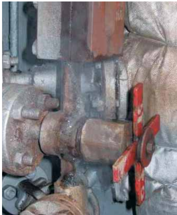
Негерметичность запорного игольчатого клапана указателя уровня
