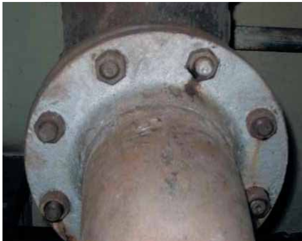
Фланцевое соединение задвижки Ду150, Ру40 установленное с перекосом
