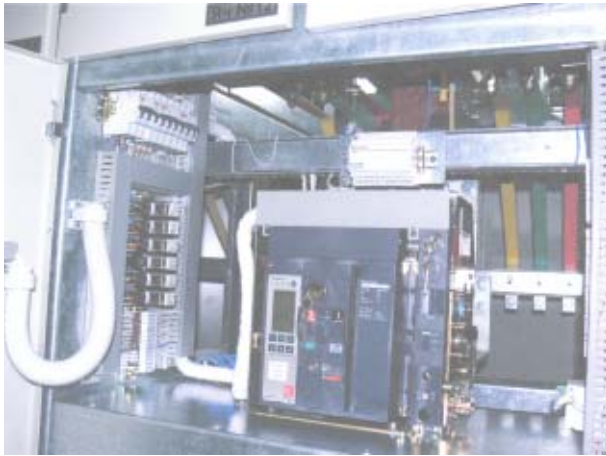
Рис. 1. Masterpact NT с блоком контроля и управления Micrologic P в ячейке РУ-0.4 кВ
