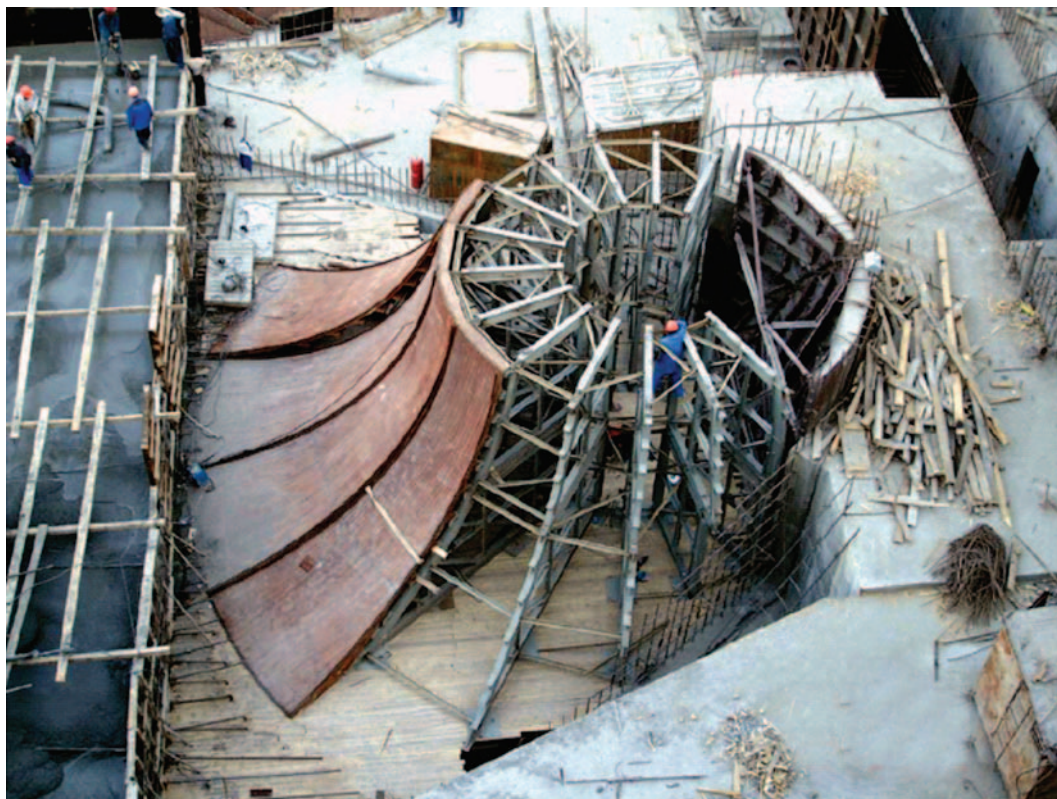
Рис. 11. Опалубка торовой части отсасывающей трубы Сангтудинской ГЭС-1
