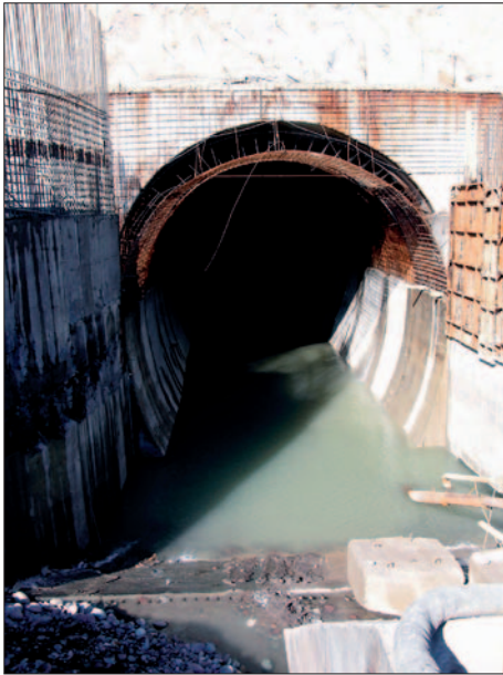
Рис. 5. Правая нитка туннелей СЭВ Сангтудинской ГЭС-1. Пропуск расходов до возведения сводовой части
