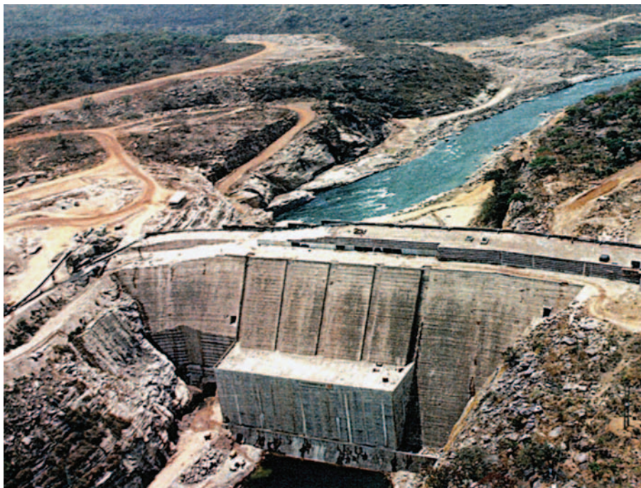
Рис. 9. ГЭС Капанда. Завершение работ по бетонированию русловой части бетонной плотины
