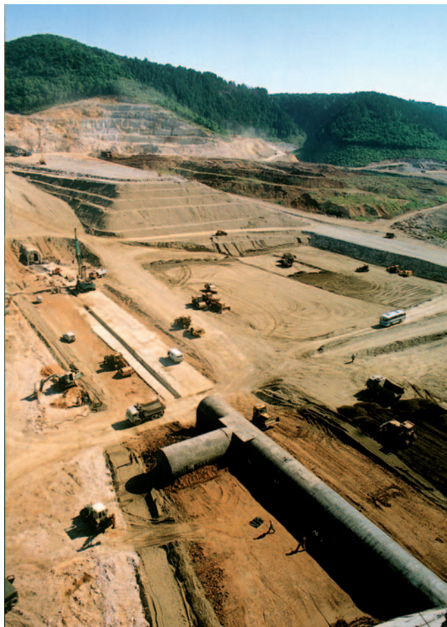
Рис. 4. Общий вид участка противофильтрационных работ Юмагузинского гидроузла
