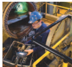
Обследование электроэнергетической установки экономайзера высокого давления
