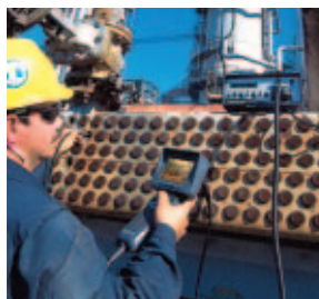
Обследование теплообменника на нефтеперерабатывающем заводе
