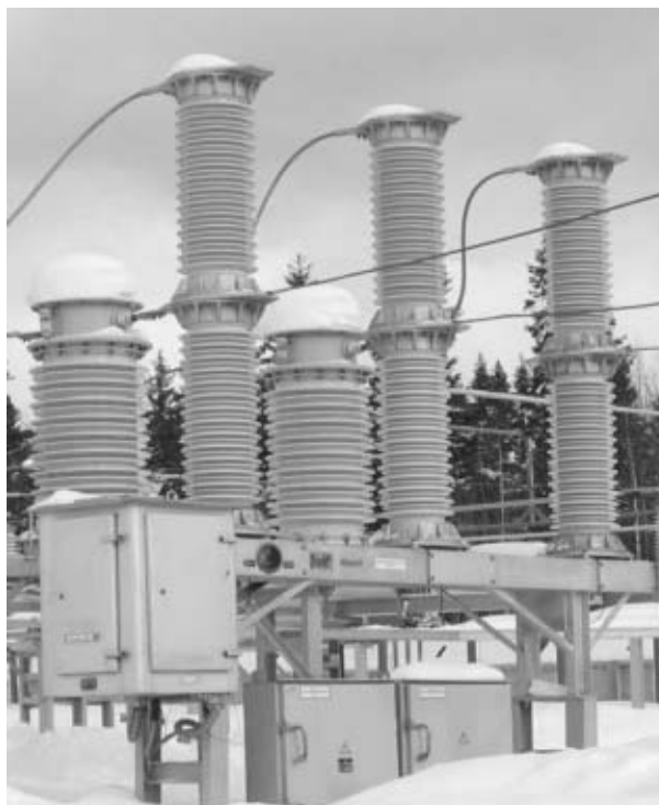
Рис. 2. Элегазовый выключатель ВГТ-110П-40/2500 (110 кВ)
