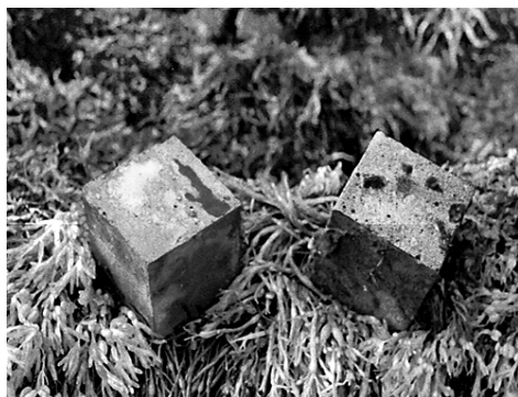
Рис. 4. Общий вид образцов бетона с микрокремнезёмом после 43 лет испытаний (состояние — 10 баллов по 10-ти бальной шкале С.В. Шестоперова).
