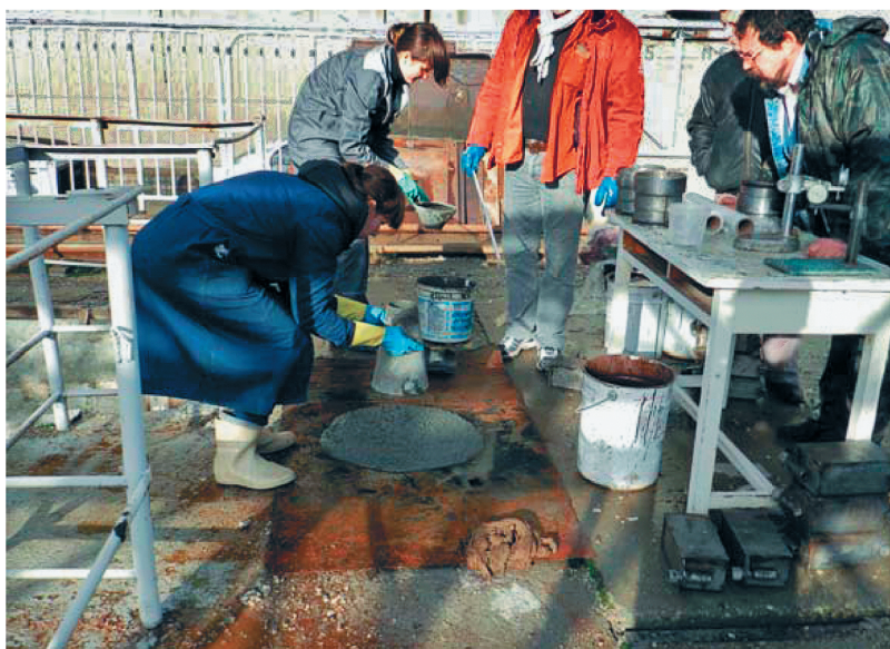
Рис. 13. Замер подвижности бетонной смеси на месте укладки
