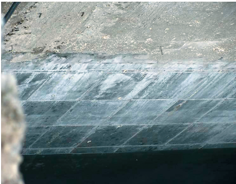
Рис. 12. Распорная балка ГА №16, вторая секция. Высота — 4,9 м, глубина — 0,3 – 0,4 м, длина — 12 м
