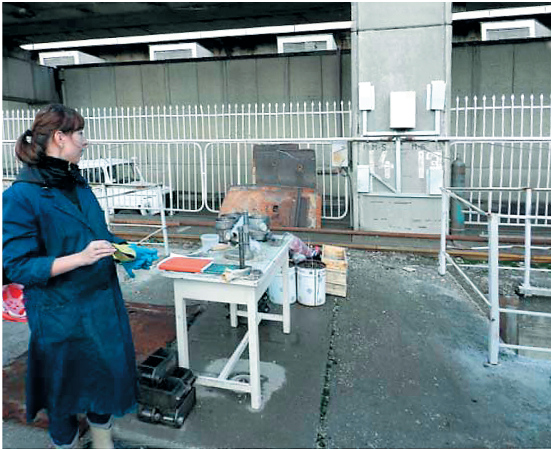
Рис. 7. Пост контроля укладываемой смеси
