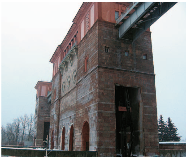
Рис. 5. Башни верхней головы. Облицовочная плитка, не покрытая инеем, не имеет сцепления со стеной
