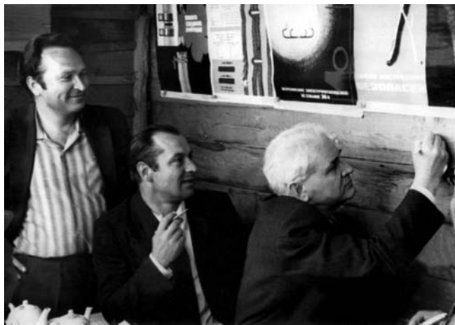
Рогунская ГЭС на р. Вахш (Таджикистан), 1997 г. П. С. Непорожний расписывается на стене вагончика изыскательской экспедиции Средазгидропроекта. Слева направо: Г. И. Тихонов, начальник треста “Таджикгидроэнергострой”, Н. Г. Савченков, начальник строительства Рогунской ГЭС
