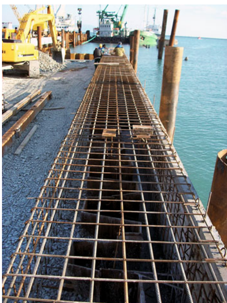
Рис. 4. Устройство железобетонного оголовка корневой части пристани № 4
