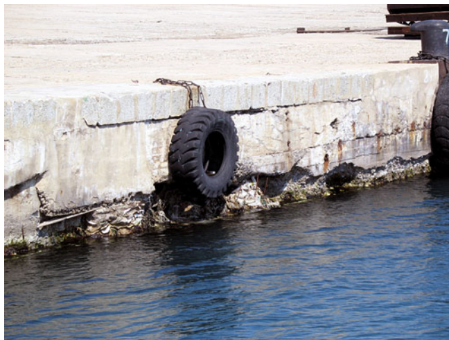
Рис. 4. Разрушения лицевой стенки массива гиганта
