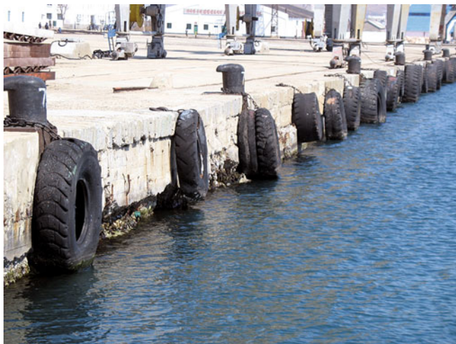
Рис. 3. Существующие отбойные устройства на причалах № 8, 9
