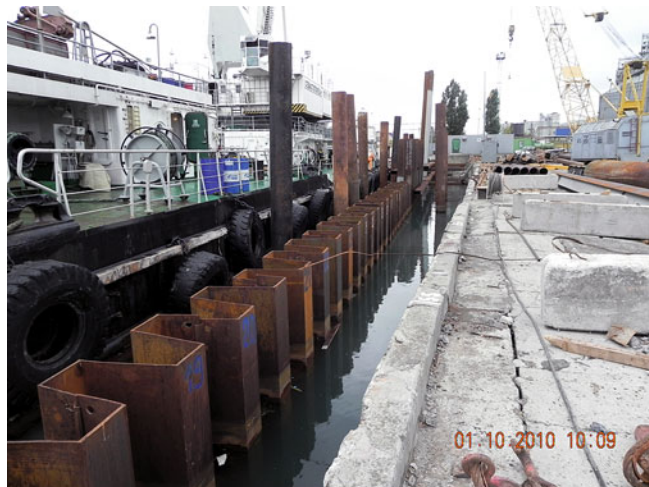
Рис. 3. Строительство корневой части пристани № 4
