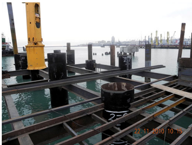
Рис. 5. Строительство эстакадной части пристани № 4
