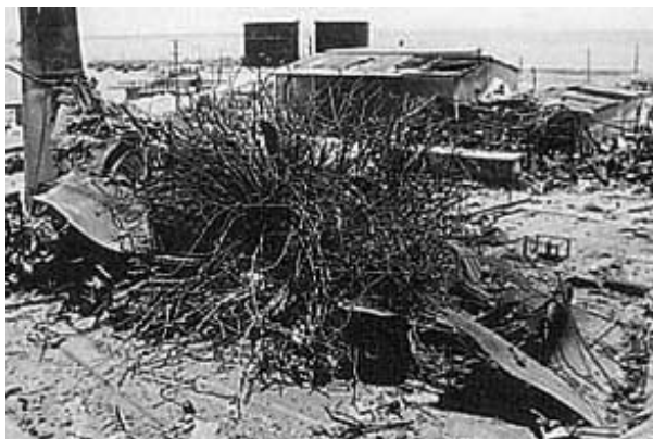
Рис. 1. Картина полного разрушения котельной установки как свидетельство опасности взрыва в топке
