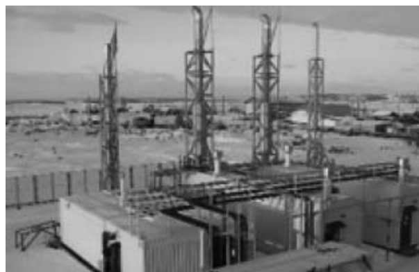
Фото ТЭС (слева направо): «пиковая» котельная, генераторные установки PG750B и резервный дизель-генератор. На переднем плане — контейнер с НКУ
