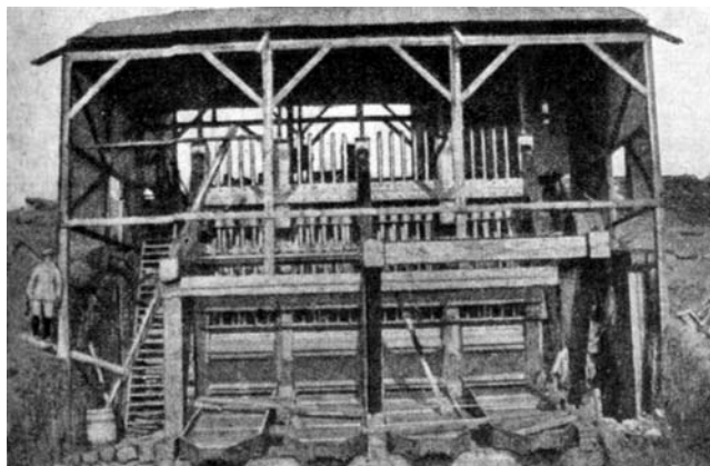
Рис. 3. Гидровашгерт для отмыва золотосодержащих песков
