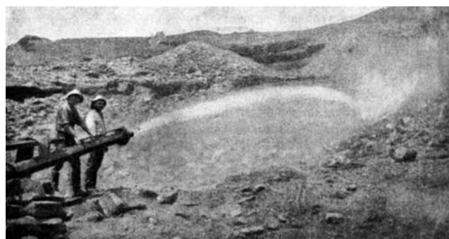
Рис. 2. Размыв карьера песков с помощью гидромонитора (США, Калифорния, 1901 г.)
