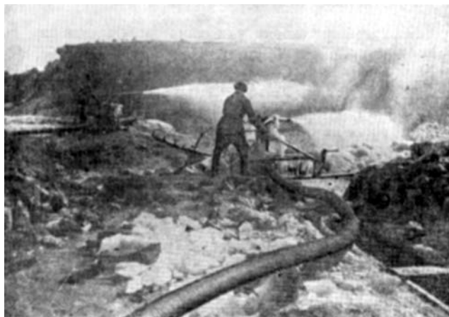
Рис. 4. Разработка выемки канала Москва — Волга с помощью гидромониторов (Пестовский бугор, зима 1934 г.)
