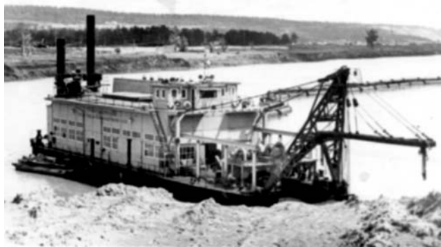
Рис. 5. Самый мощный земснаряд 1000 – 80 производит выемку канала № 34 (строительство Куйбышевской ГЭС, зима 1953 г.)
