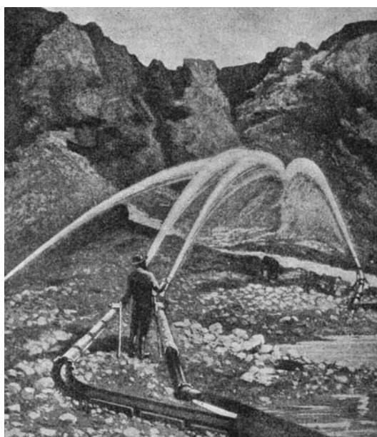
Рис. 1. Разработка карьера золотоносного песка с помощью гидромониторов (США, Калифорния, 1880 г.)
