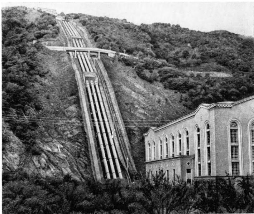
Рис. 2-45. Напорный турбинный трубопровод и здание Храмской ГЭС I.
