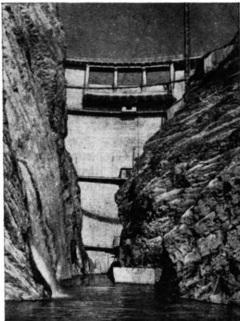
Рис. 2-36. Арочная плотина Ладжанурской ГЭС. Вид с нижнего бьефа в процессе строительства.
