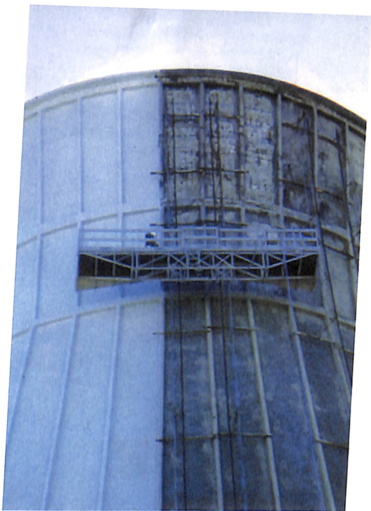
• Покрытие футеровки градирни материалами серии ЭМАКО (к статье Затворницкой Т.А., Магитон А.С., Козлова Г.Н.)
