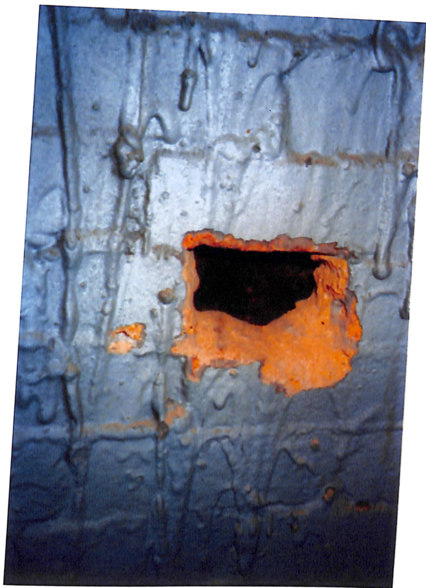
Отверстие в футеровке трубы для заполнения КОНСИЛОм
