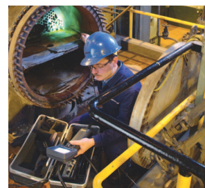
Обследование электроэнергетической установки экономайзера высокого давления
