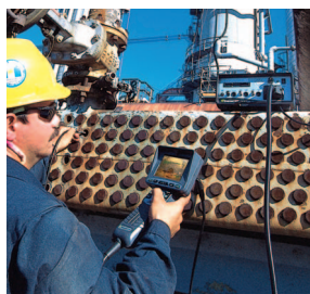
Обследование теплообменника на нефтеперерабатывающем заводе
