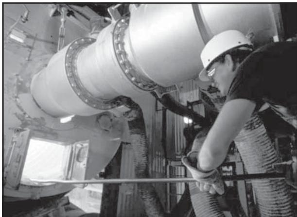
Использование частотно-регулируемых электроприводов для управления механизмами котельных установок, с энергетической и с технологической точек зрения, намного эффективнее традиционно используемого управления задвижками, шиберами и направляющими аппаратами в воздушных, газовых и водных магистралях котла.
