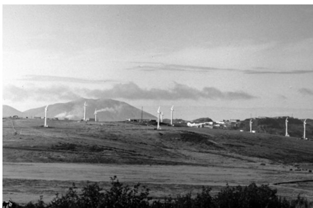
Рис. 1. Чукотская ВЭС-1. Общий вид
