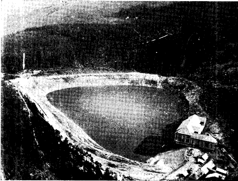
FIG. 1 — Le Lac Noir — Vue générale. La digue est indiquée par une flèche.
