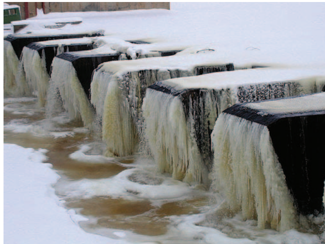
Рис. 1. Сброс воды через лабиринтный водосброс Хоробровской МГЭС, 20 января 2004 г.
