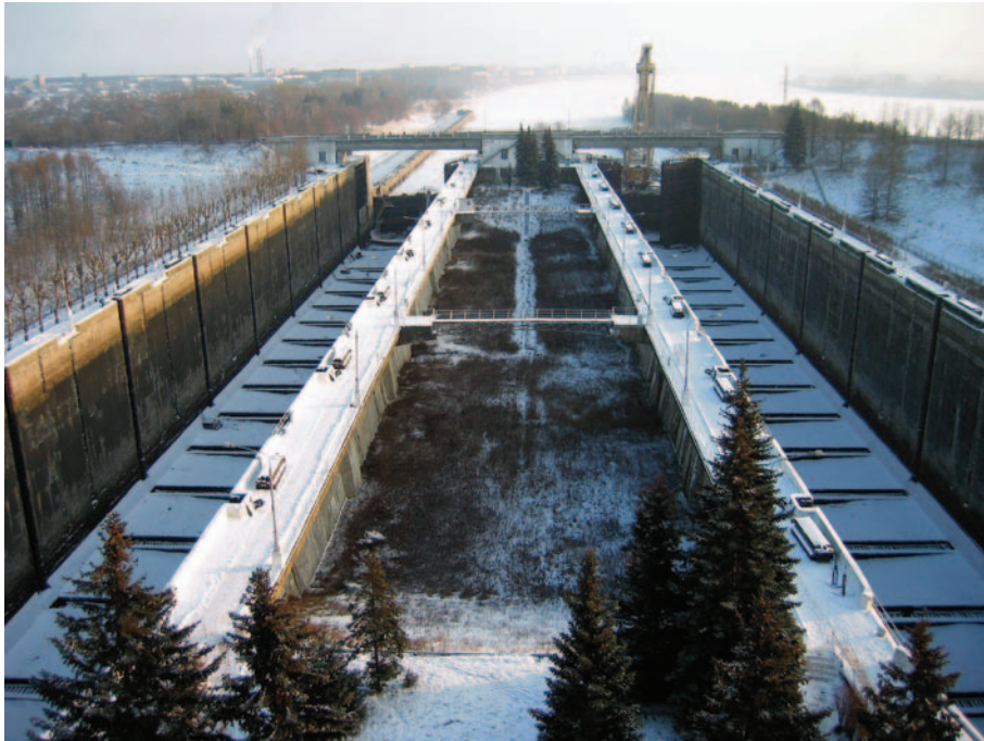
Рис. 1. Камеры шлюза, освобожденные от воды
