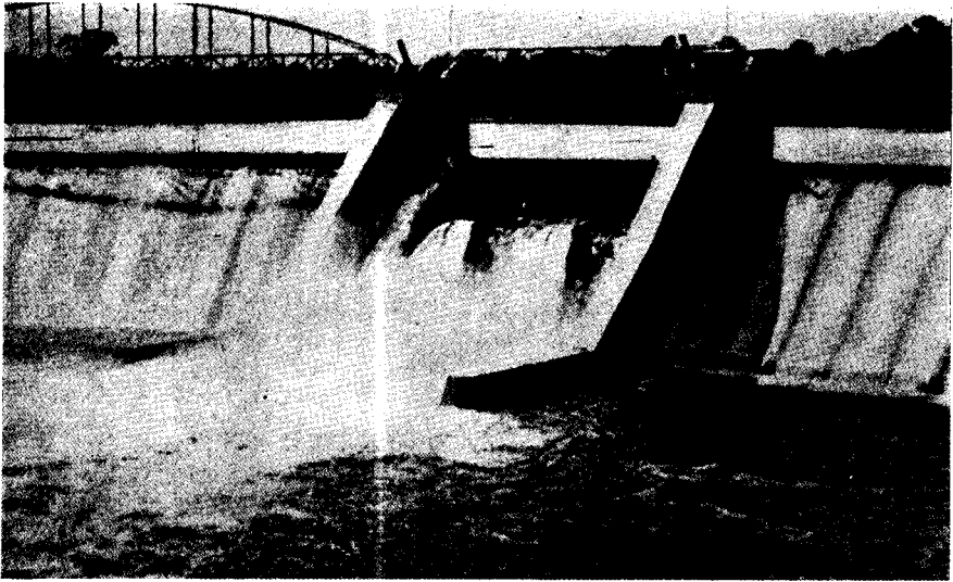
Fig. 6. Sektordurchlass bei der Chenderoh Wasserkraftanlage in Hinter-Indien. Strahlspalter an der Erguss-Seite des Wehres. Der Sturzboden wird von Leitmauern begrenzt.
