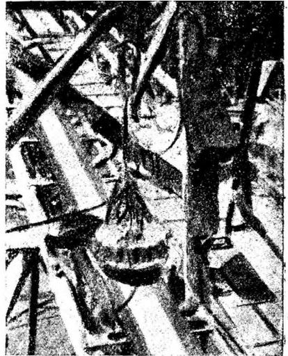
Рис. 464. Подача инертных по ленточному транспортеру.
