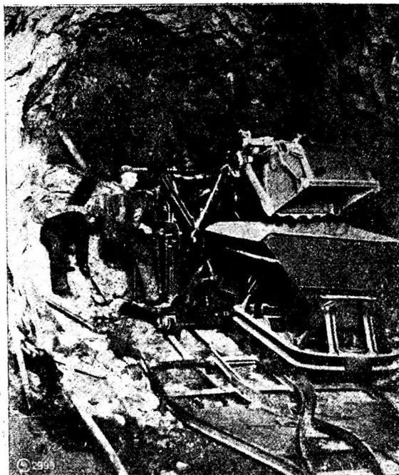
Рис. 284. Экскаватор Бутлер в работе.
