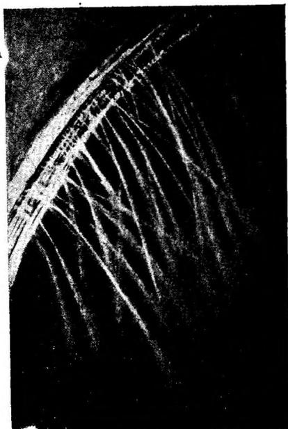
Рис. 39. Выход грунтовых вод через трещины.
