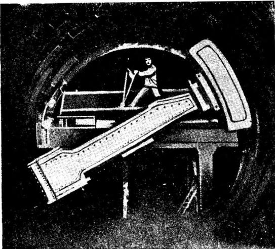
Рис. 114. Укладка камней в тело облицовки эректором.
