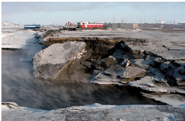
Рис. 3. Размыв мерзлого грунта месторождения в потоке
