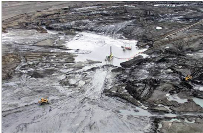
Рис. 7. Гидромеханизированная система разработки
