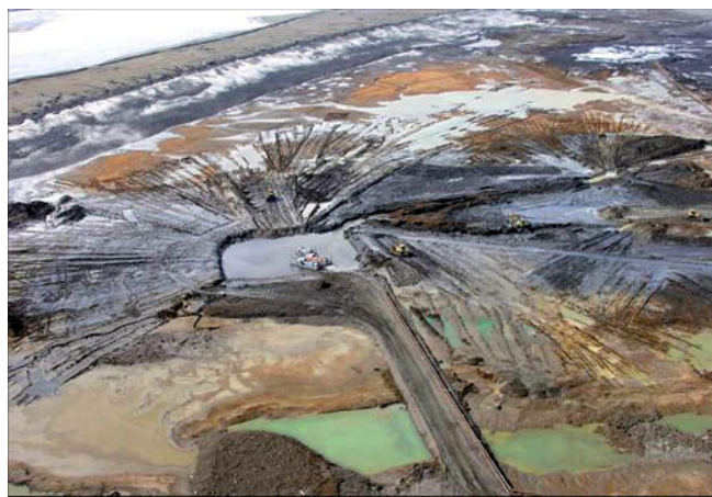
Рис. 10. Разработка минерального сырья во вспомогательном котловане
