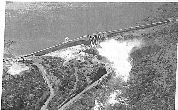
Рис. 1. Гидроузел «Капанда» при сбросе воды из верхнего бьефа через 4-й поверхностный водосброс и два донных водосброса ( http://www.hydroproject.ru )
