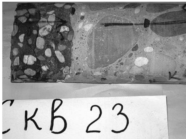
Рис. 1. Скважина № 23, поперечные трещины в наружном слое
