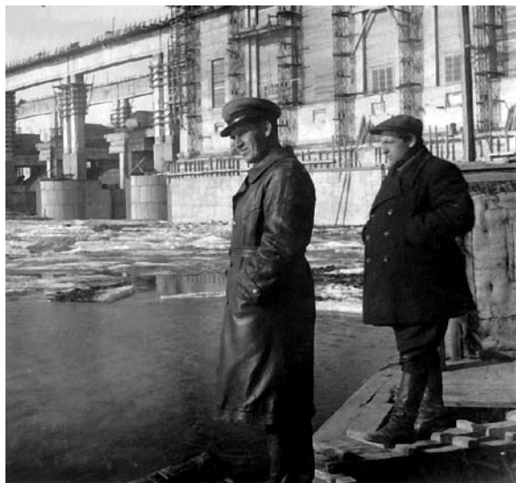
Рис. 3. Начальник третьего участка младший лейтенант М. Л. Ключин на фоне строящегося здания ГЭС. СССР, Ярославская обл., г. Рыбинск. 1939 – 1940 гг. РБМ-24284. ФС-4828 (фонд Рыбинского краеведческого музея)
