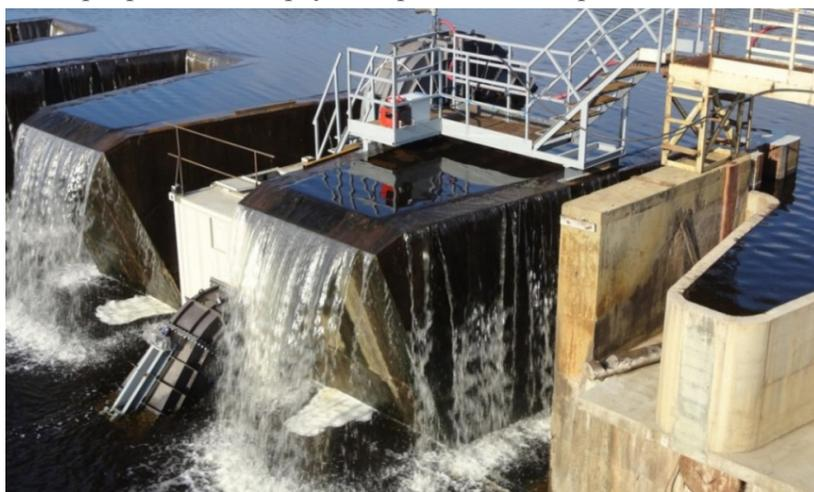
**Рис. 10.** Опытная мини-ГЭС с 30 кВт-гидроагрегатом на Хоробровском гидроузле
