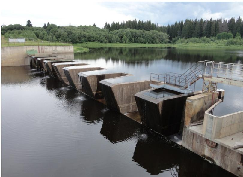
**Рис. 2.** Вид на водослив Хоробровской малой ГЭС со стороны нижнего бьефа
