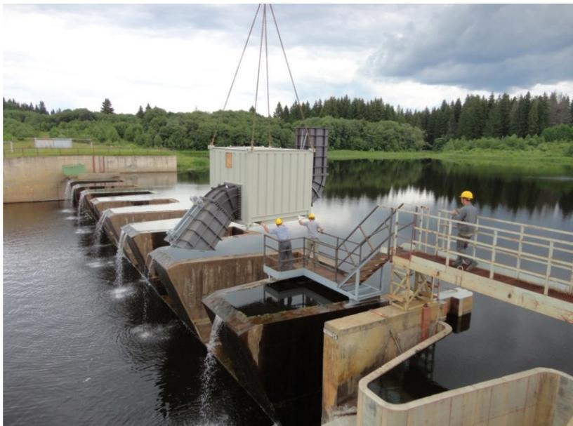
**Рис. 8.** Установка энергоблока мини-ГЭС в секцию водосливной плотины Хоробровского гидроузла
