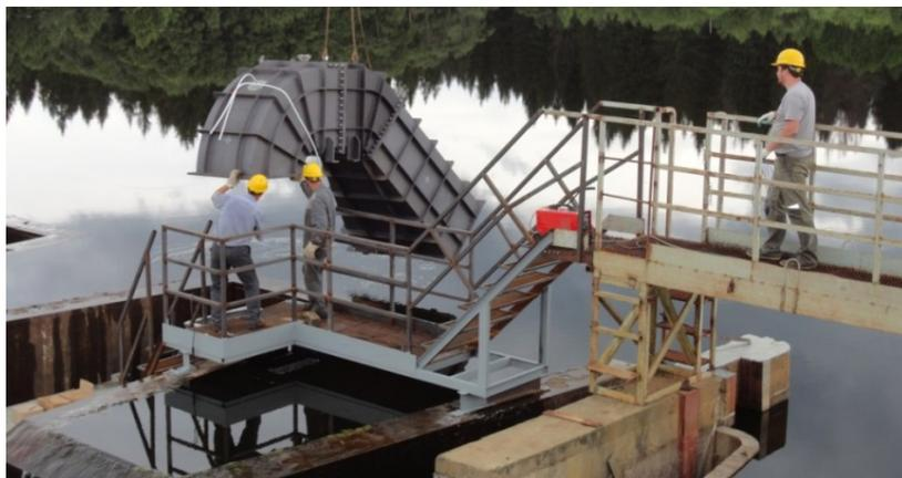
**Рис. 9.** Установка входящего оголовка водовода
