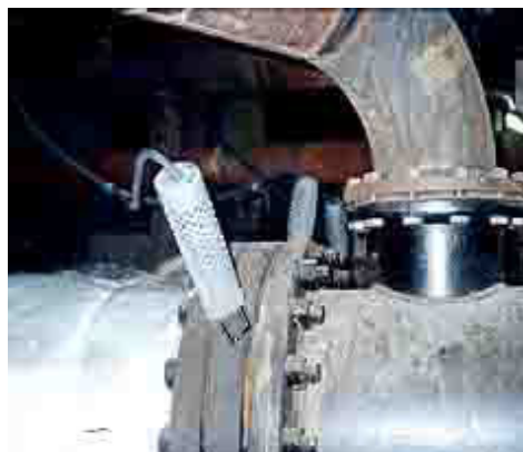
Рис. 3 и 4. Монтаж УЗ-преобразователей на пластинчатом и пароводяном теплообменниках
