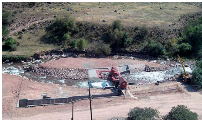
Рис. 4. Водозаборное сооружение для деривационной ГЭС (ВСДГ), построенное в 2010 г. на р. Мерке в Меркенском районе Джамбульской области, Казахстан
