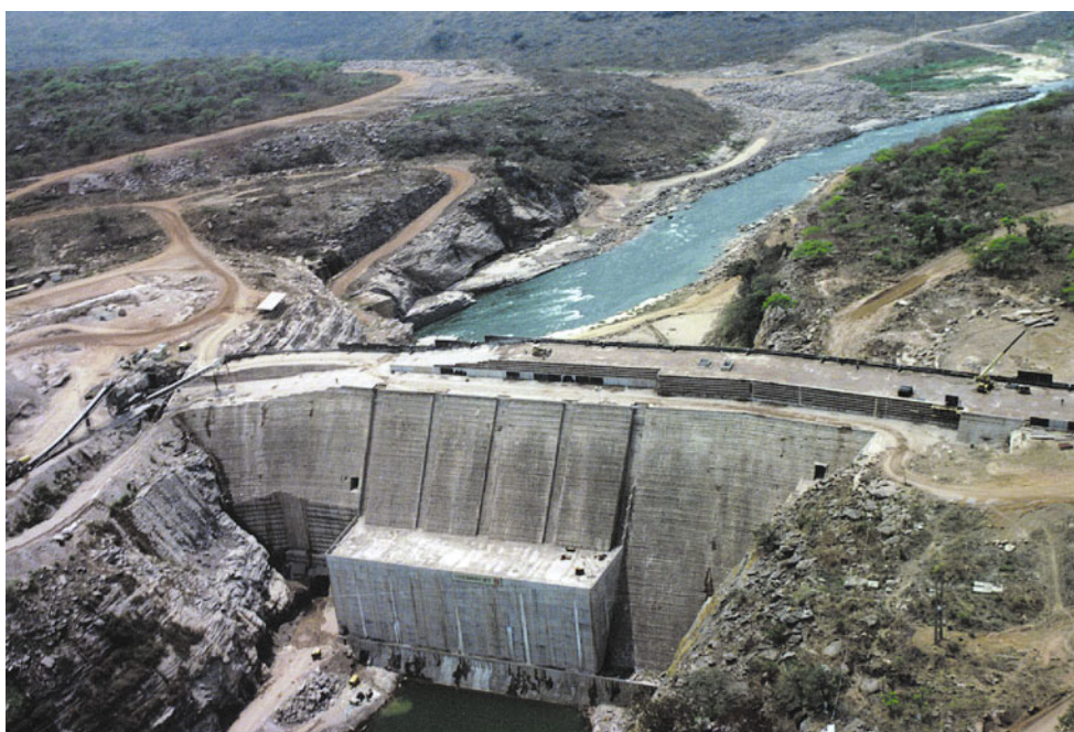
Рис. 1. Плотина Капанда на завершающей стадии строительства
