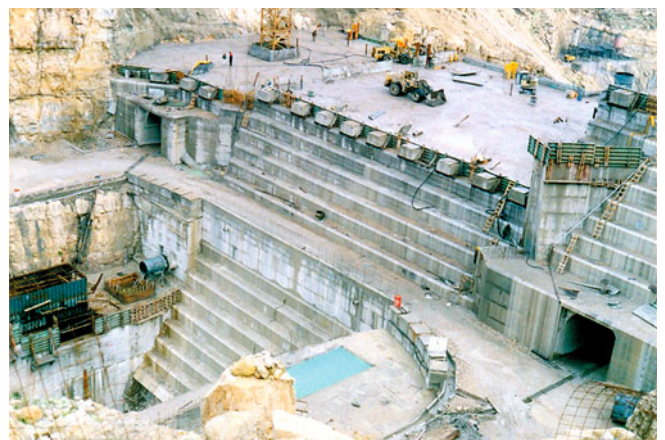
Рис. 6. Формирование ступенчатой низовой грани плотины Коусар
