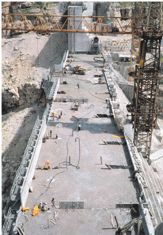
Рис. 3. Строительство плотины Коусар высотой 144 м
