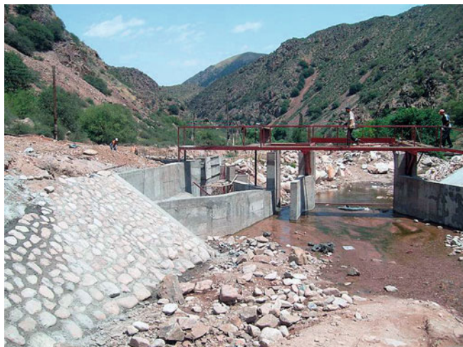
Рис. 3. Ломаный в плане наносозащитный порог с криволинейным профилем гребня (слева) в составе ВСДГ на р. Мерке на этапе строительства
