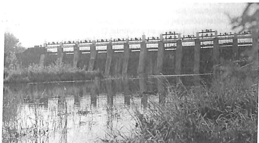
Рис. 1. Вид водосливной плотины Сызранского гидроузла со стороны нижнего бьефа.
