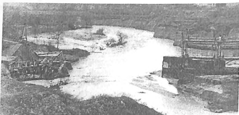
Рис. 2. Головное сооружение Талигулянской ГЭС-1 после аварии.
