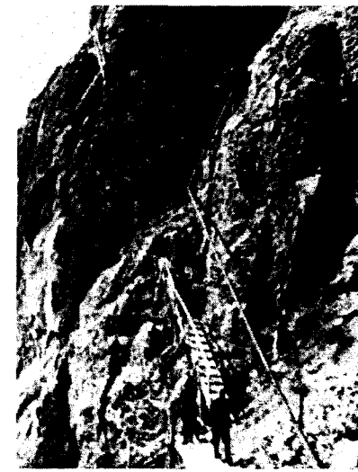
Рис. 6.5. Защитная полка и трап на Токтогульской ГЭС
