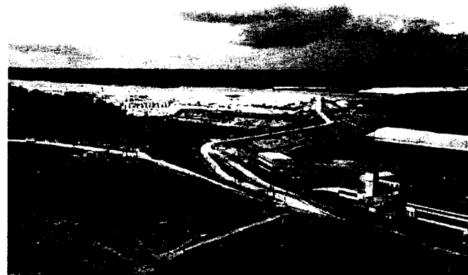
Рис. 5.4. Общий вид котлована основных сооружений Чебоксарской ГЭС
