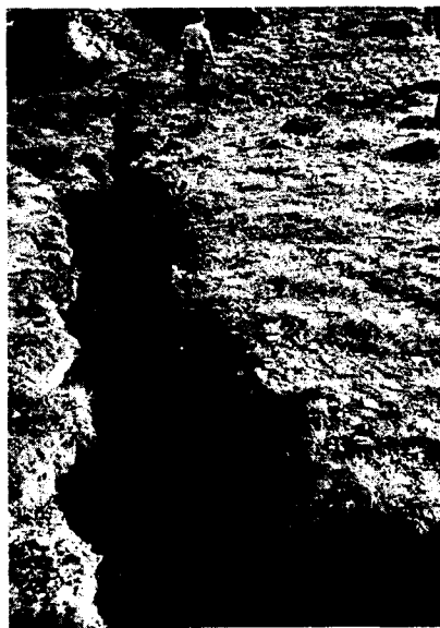
Рис. 6.3. Трещина бортового отпора на правом берегу Чиркейского створа
