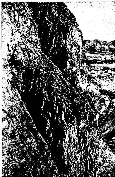
Рис. 4.13. Потенциально-неустойчивый скальный массив в районе перекрытия русла Сулака
