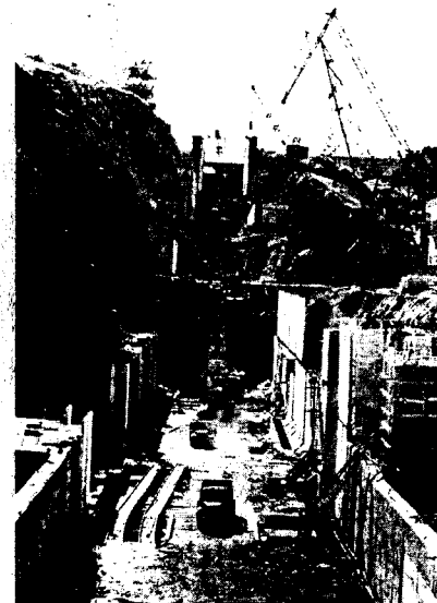
Рис. 7.5. Опалубка из армопанелей на шлюзе Бухтарминской ГЭС
