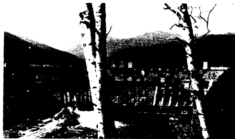
Рис. 2.10. Строительство Саяно-Шушенской ГЭС. Вид с нижнего бьефа
