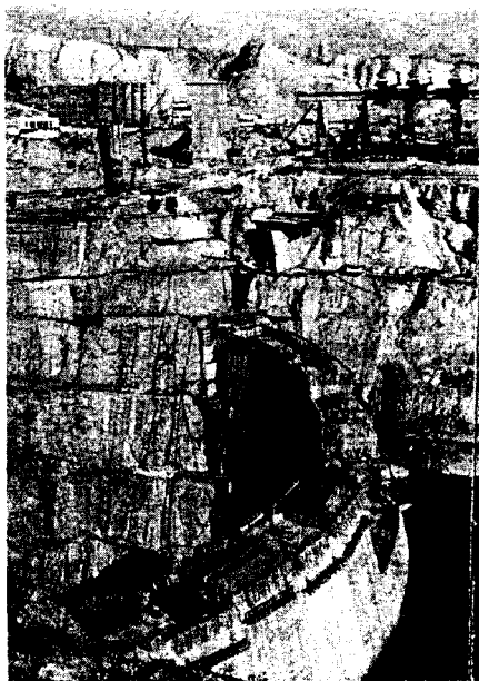
Рис. 7.12. Бетонирование арочной плотины Чиркейской ГЭС кабель-краном при секционной разрезке на блоки
