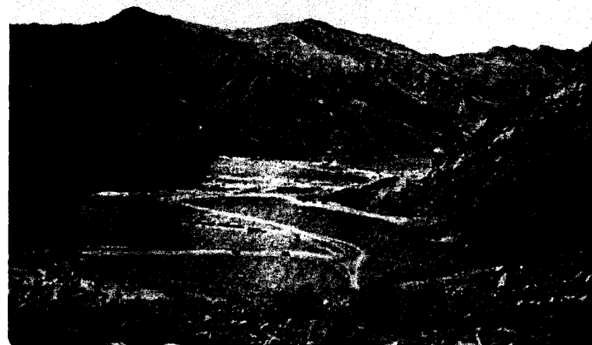
Рис. 2.21. Нурекская ГЭС на р. Вахш – вид на строительство каменно-земляной плотины с нижнего бьефа
