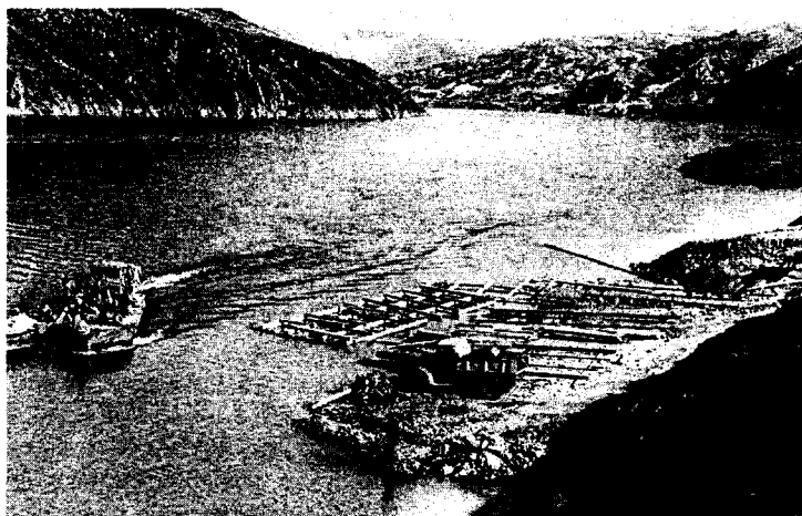
Рис. 5.13. Рубка рьяей перемычек 1-й очереди Бухтарминской ГЭС на береговом стапеле осенью 1954 года
