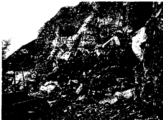
Рис. 6.11. Завал защитной полки скалой на правом борту котлована Чиркейской ГЭС землетрясением 14 мая 1970 года
