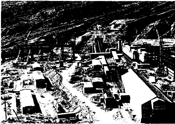
Рис. 7.13. Параллельный кабель-кран на эстакадах на плотине Чиркейской ГЭС
