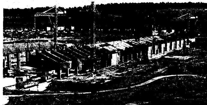
Рис. 7.40. Расстановка башенных кранов на строительстве здания гидроэлектростанции Чебоксарского гидроузла
