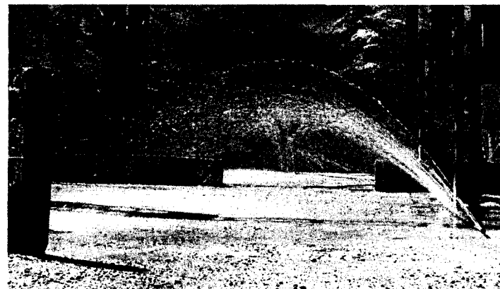
Рис. 8.24. Поверхностное охлаждение поливом водой на Токтогульской плотине
