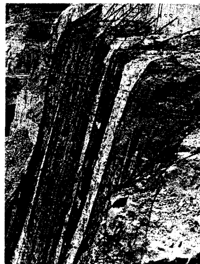
Рис. 6.4. Защита левобережного откоса котлована Чиркейской ГЭС металлической сеткой
