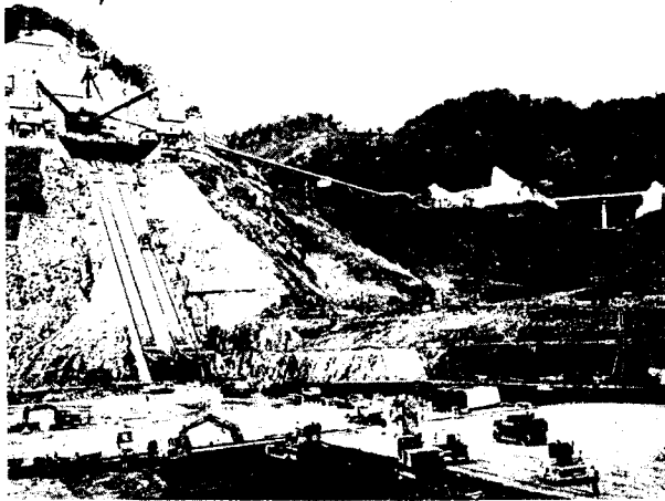
Рис. 7.31. Возведение плотины Томагава в Японии из укатанного бетона
