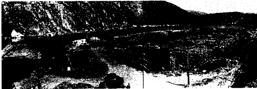
Рис. 5.15. Общий вид котлована первой очереди Бухтарминской ГЭС в период строительства её перемычек весной 1955 года
