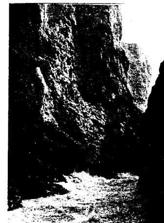
Рис. 3.28. Ущелье р. Сулак в районе выходных порталов строительного тоннеля и эксплуатационного водосброса
