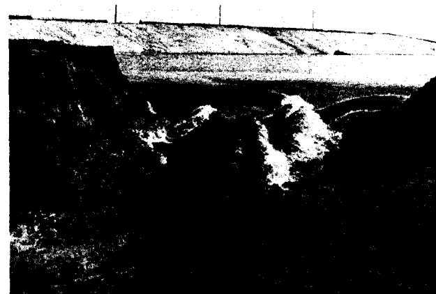
Рис. 5.34. Размыв песчаной перемычки потоком после взрыва ее на Чебоксарской ГЭС
