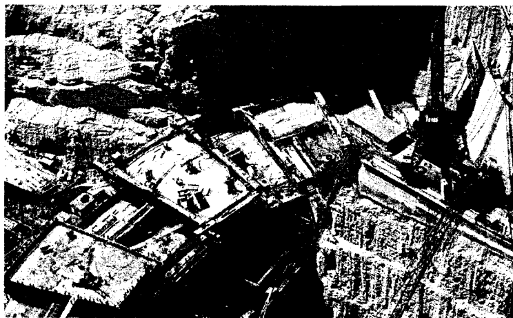
Рис. 7.20. Бетонирование нижних секций арочной плотины Чиркейской ГЭС в самоподъемной механизированной опалубке
