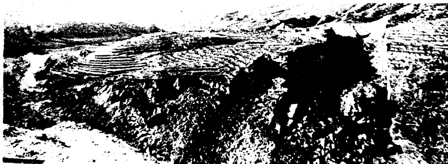
Рис. 6.8. Завал русла р. Сулак скальным оползнем выше временного поселка гидростроителей при землетрясении 14 мая 1970 года
