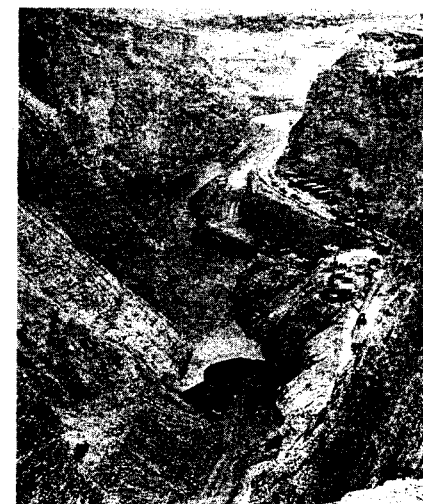
Рис. 4.15. Ущелье реки Сулак после перекрытия русла направленным массовым взрывом на Чиркейской ГЭС
