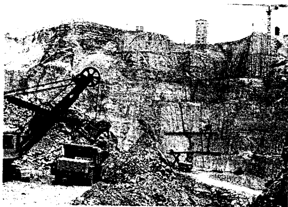
Рис. 6.24. Разработка береговых примыканий арочной плотины Чиркейской ГЭС экскаваторами на транспорт с устройством автоподъездов к каждому ярусу
