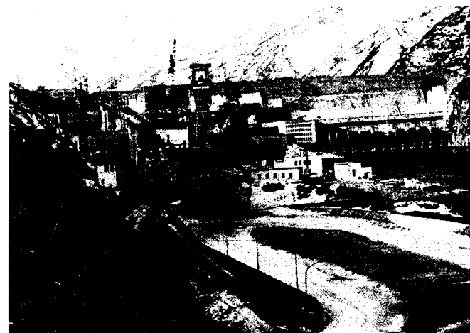
Рис. 3.16. Бухтарминская ГЭС. Общий вид четырех камерного шлюза
