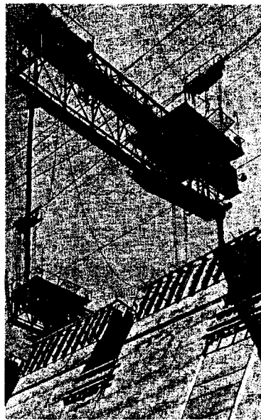
Рис. 7.15. Кабель-кран с распределительным мостом
