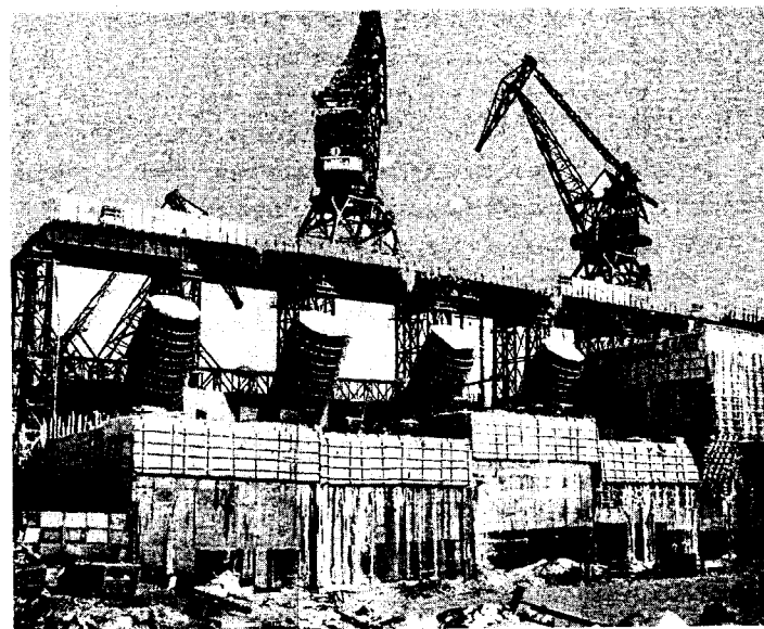
Рис. 8.10. Подвижные бетоноукладочные шатры на плотине Бухтарминской ГЭС зимой 1959-60 г.
