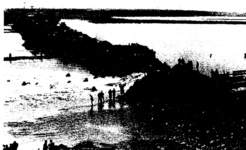
Рис. 4.17. Перекрытие р. Даугавы пионерным способом на Рижской ГЭС с использованием бетонных негабаритов весом до 10 тонн
