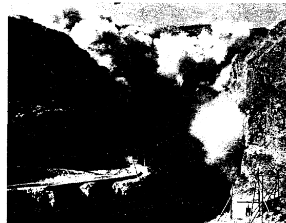
Рис. 4.14. Перекрытие русла р. Сулак направленным массовым взрывом на Чиркейской ГЭС
