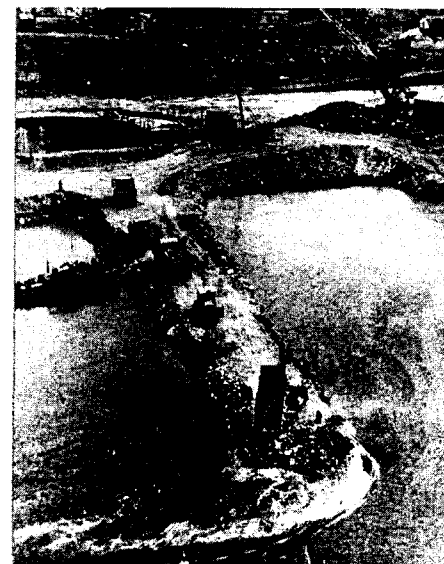
Рис. 4.4. Отсыпка банкета из горной массы при пионерном перекрытии р. Иртыша на Бухтарминской ГЭС в 1956 г.
