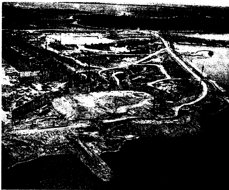
Рис. 4.7. Сужение русла р. Волги намывом пирса из гравийно-песчаной смеси со стороны котлована на Чебоксарской ГЭС
