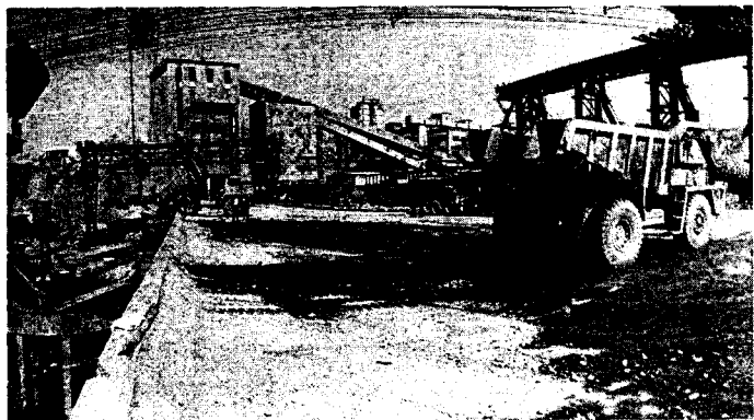
Рис. 7.17. Узел загрузки бадей под кабель-кран на плотине Чиркейской ГЭС
