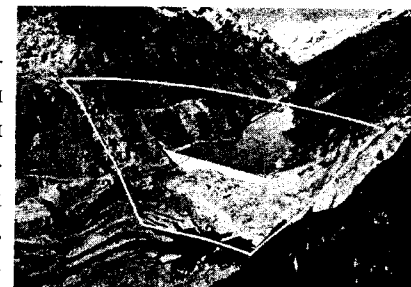
Рис. 5.21. Бетонная перемычка ГЭС Рейс Мулен в Италии
