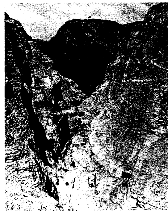
Рис. 6.28. Котлован арочной плотины и приплотинной гидроэлектростанции со двоянными агрегатами Чиркейской ГЭС на р. Сулак
