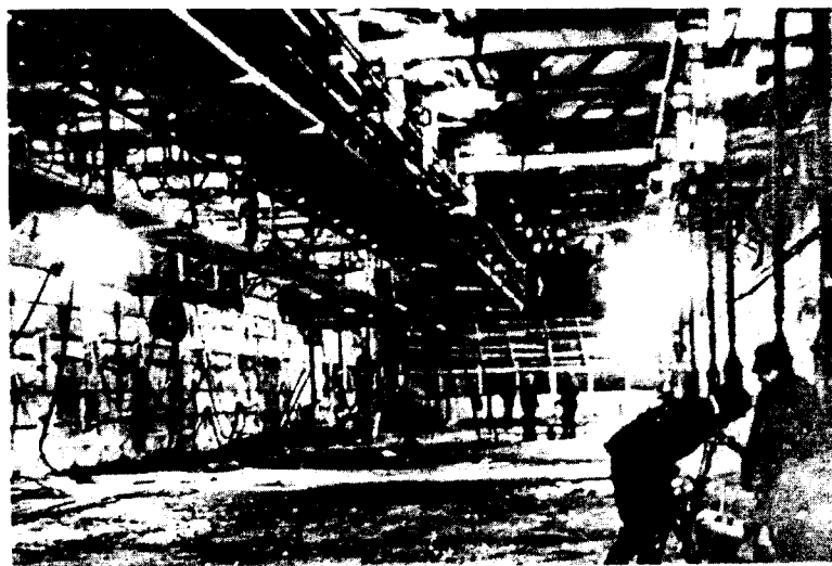
Рис. 8.29. Внутренний вид подвижного шатра ЛОЭС при непрерывно-конвейерном бетонировании плотины Красноярской ГЭС
