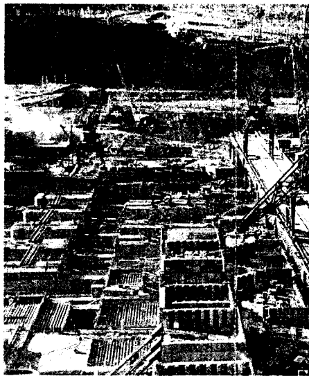
Рис. 7.3. Бетонирование плотины Братской ГЭС столбчатыми блоками в опалубке из массивных бетонных блоков
