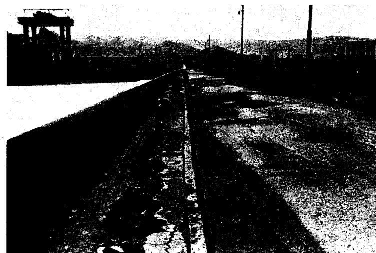
Рис. 2.26. Плотина Чириюртской ГЭС после Дагестанского землетрясения 1970 года
