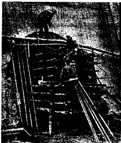
Рис. 6.22. Монтаж предварительно-напряженных анкеров в штольне при креплении левого борта в створе Чиркейской ГЭС
