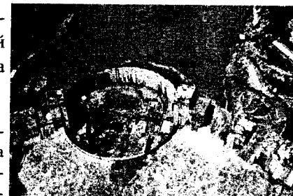
Рис. 5.22. Бетонная затопляемая перемычка на ГЭС Кариба
