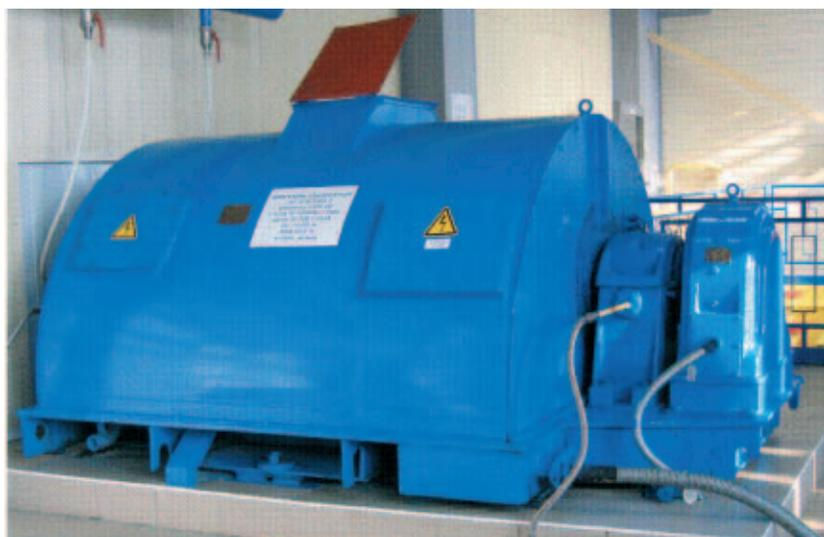
**Рис. 4.1. Синхронный электродвигатель с БВУ (бесщеточным возбудительным устройством)**
