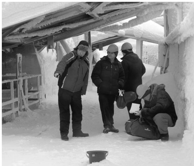
Рис. 4. Точка измерений № 3. Балкон на отметке 440 м
