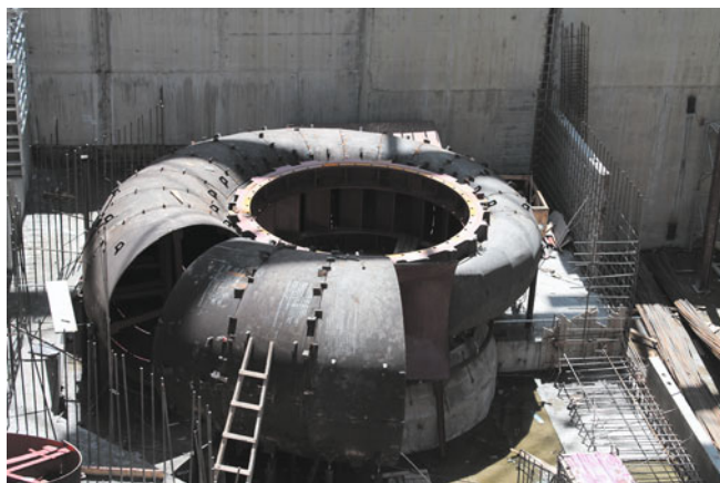
Монтаж спиральной камеры Гоцатлинской ГЭС
