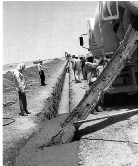
Рис. 7. Укладка грунтоцемента в стенку-диафрагму в ядерной части плотины Вади Хавазинах (Оман)
