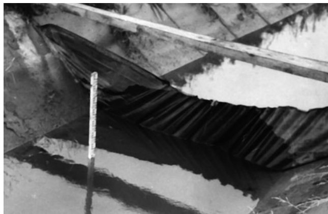
Рис. 1. Фрагмент изолированного отсека с мягкими водонепроницаемыми перегородками из полимерных материалов на канале 4х-1 Кисловской ОС
