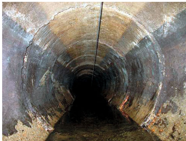
Рис. 3, б. Устьевой участок дренажного коллектора плотины № 3. Вид после выполнения очистки
