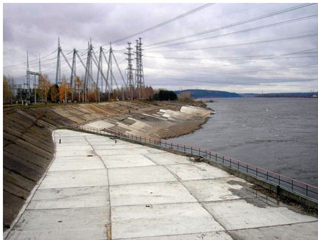
Рис. 4. Современное состояние крепления левого берега
