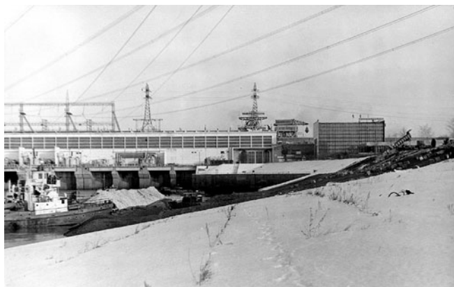
Рис. 3. Ремонт левобережного откоса
