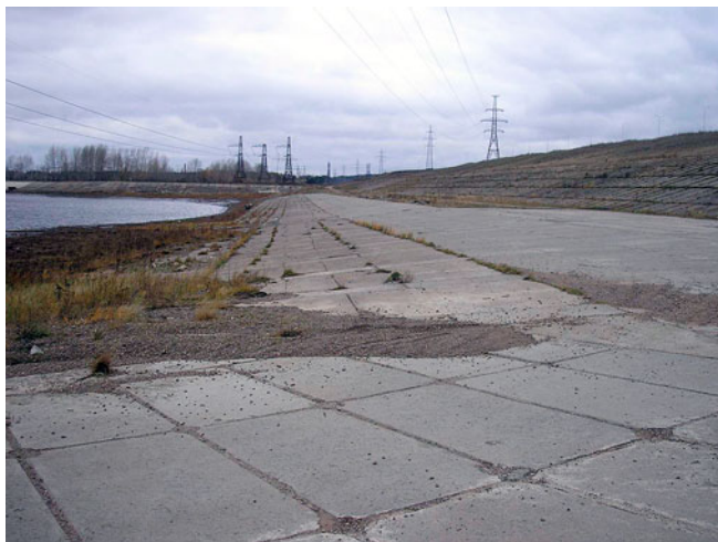
Рис. 6. Современное состояние низового откоса плотины № 1
