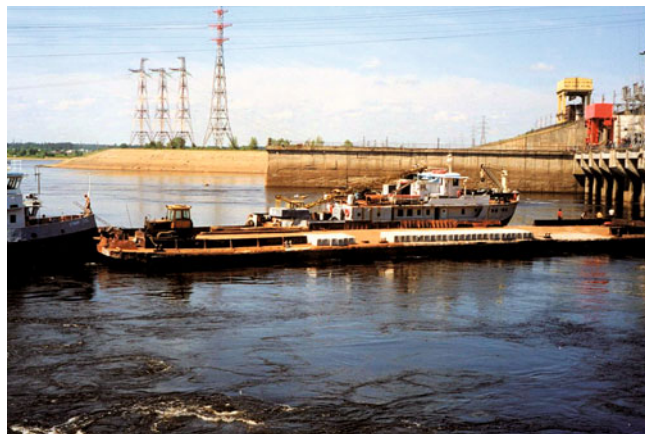
Рис. 5. Ремонт зоны размыва
