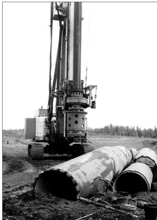
Рис. 10. Установка “Казагранде С-60” для бурения скважины диаметром 1,2 м на плотине Курейской ГЭС
