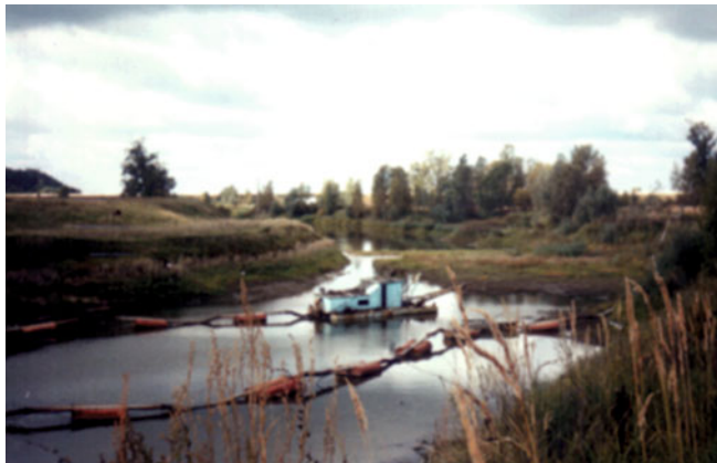
Рис. 1. Работа земснаряда по очистке канала инженерной защиты (Фокинская сельхознижина, Нижегородская область)
