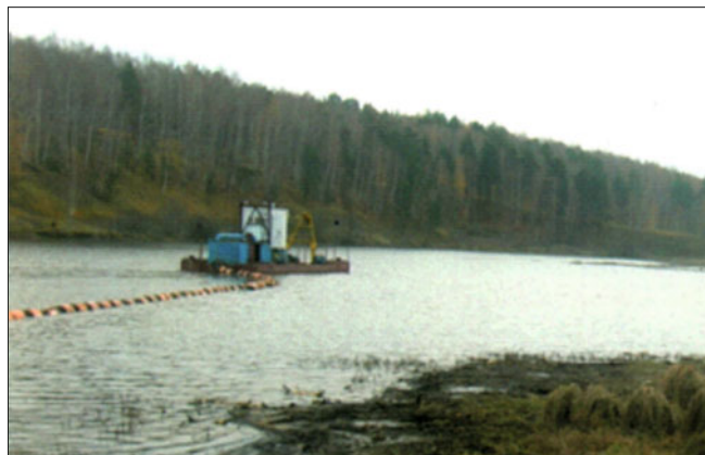
Рис. 4. Очистка водохранилища на р. Валава, г. Лысково Нижегородской области
