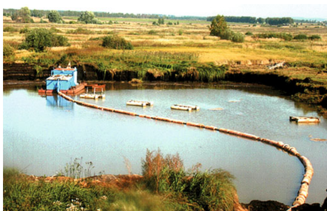
Рис. 6. Земснаряд “Нижегородец-1” на строительстве хозяйственного водоема пос. Лакша Богородского района
