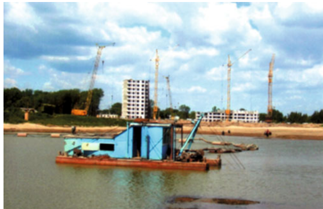
Рис. 2. Очистка и дноуглубление городского водоема в микрорайоне «Водный мир», г. Нижний Новгород
