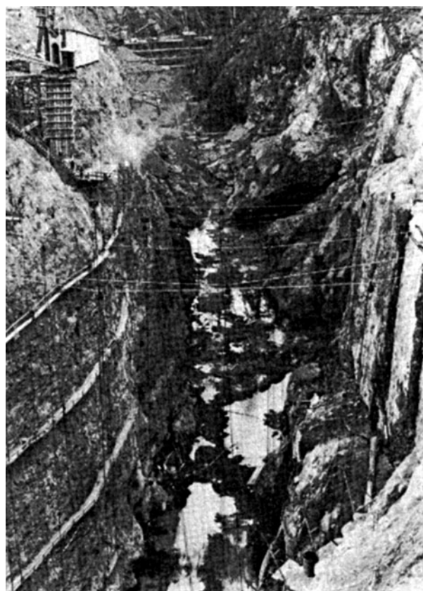
Рис. 4. Вид на котлован плотины Мад Маунтин в русле реки, разработанный под ядро до скального основания
