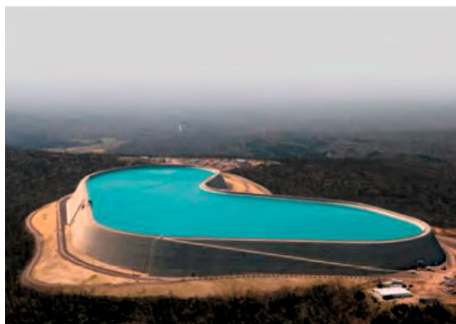
Рис. 2. Верхний бассейн гидроаккумулирующей электростанции The Taum Sauk, США
