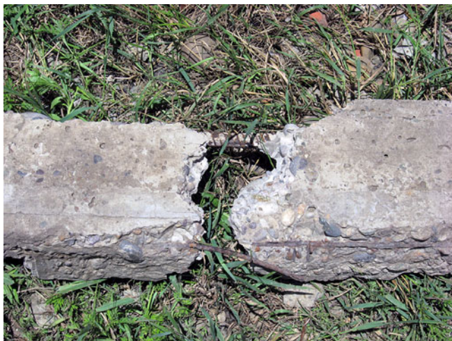
Рис. 3. Разрез, выполненный гидродинамической струей ( P = 47,0 МПа) на бетоне М500
