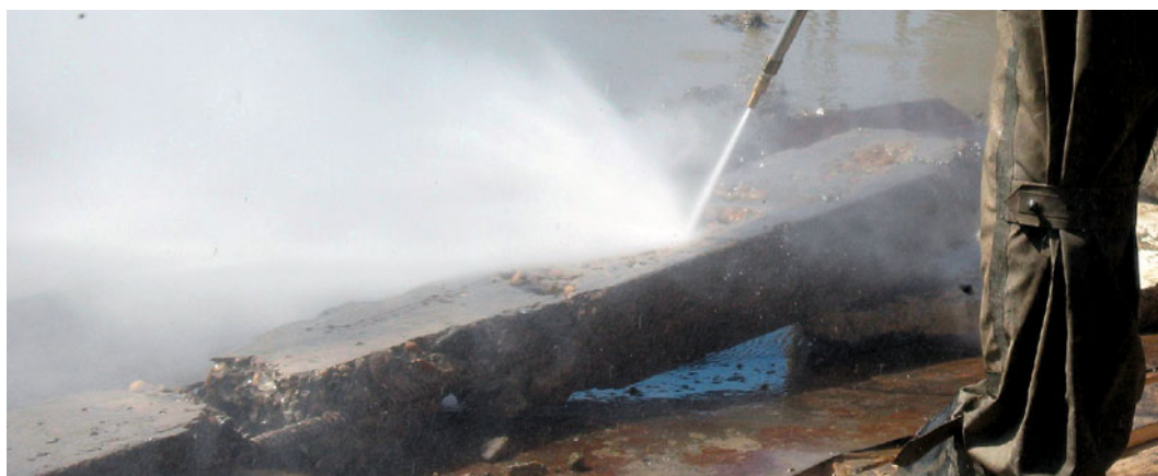
Рис. 2. Процесс удаления рыхлого корродировавшего бетона ( P = 28,0 МПа)
