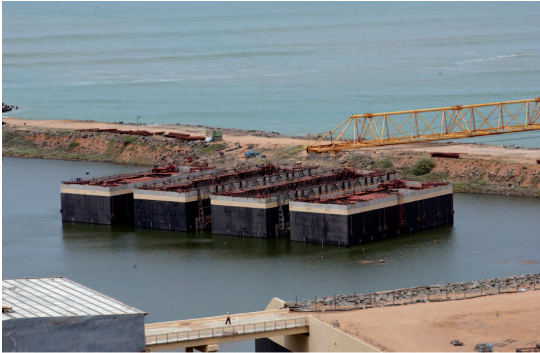
Рис. 5. Затопление котлована и всплытие наплавных блоков
