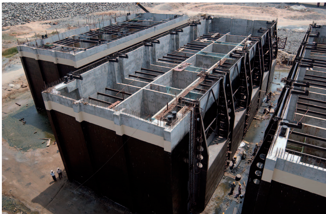
Рис. 4. Изготовление блоков на стапельном месте. Вид на наплавной блок водопропускной секции с установленными инвентарными щитами, за ним наплавной блок примыкающей секции
