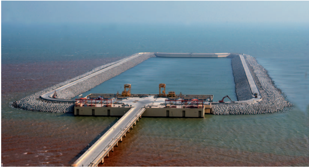
Рис. 10. Вид на законченное строительство водозаборного трубопровода
