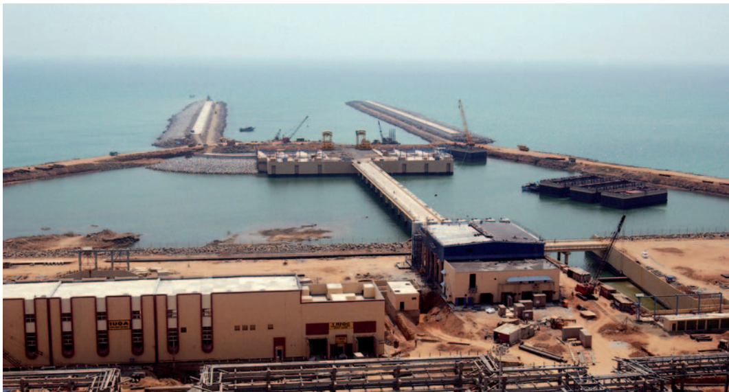
Рис. 6. Вывод из котлована наплавного блока через разобранную перемышку
