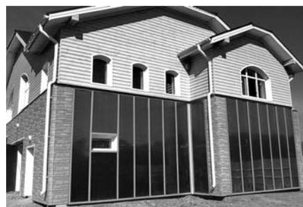
Рис. 5. СВНУ для приготовления горячей воды и поддержки системы отопления для частного дома
