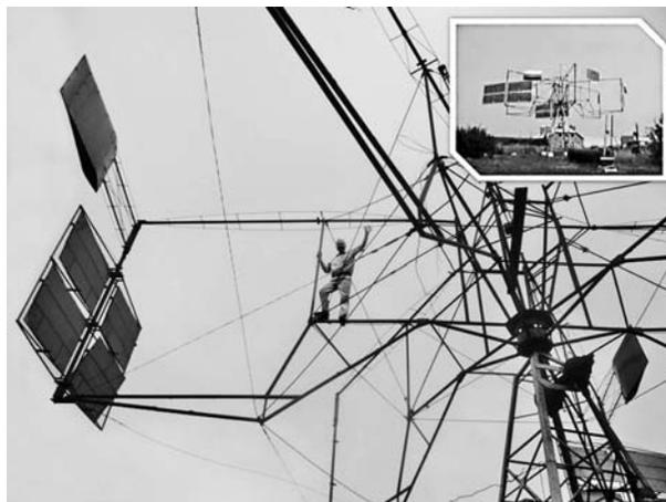
Рис. 8. Мощная карусельная парусная ВЭУ с автономными парусными узлами и автоматической защитой парусов от ветровой перегрузки, реализованная автором в г. Таганроге
