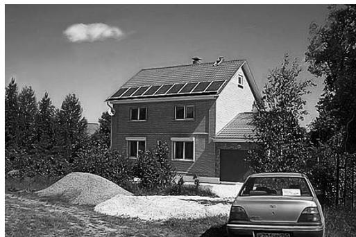
Рис. 4. ФЭС мощностью 2кВт, с. Поленово, Тульская область
