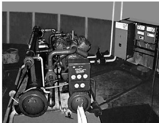
Рис. 2. Теплонасосная установка на РНС-3 «Гайва»
