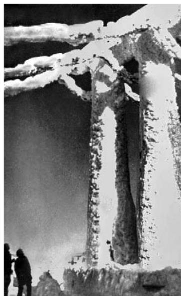
**Рис.1.** Состояние линии электропередачи после снежной бури в Павлодарской области
