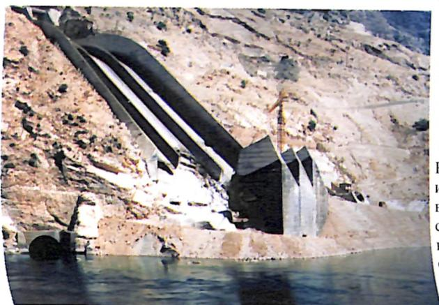
Рис. 3. Разрушены центральный и правый пролеты, основание под ними, смещен и поврежден блок носков-трамплинов.
