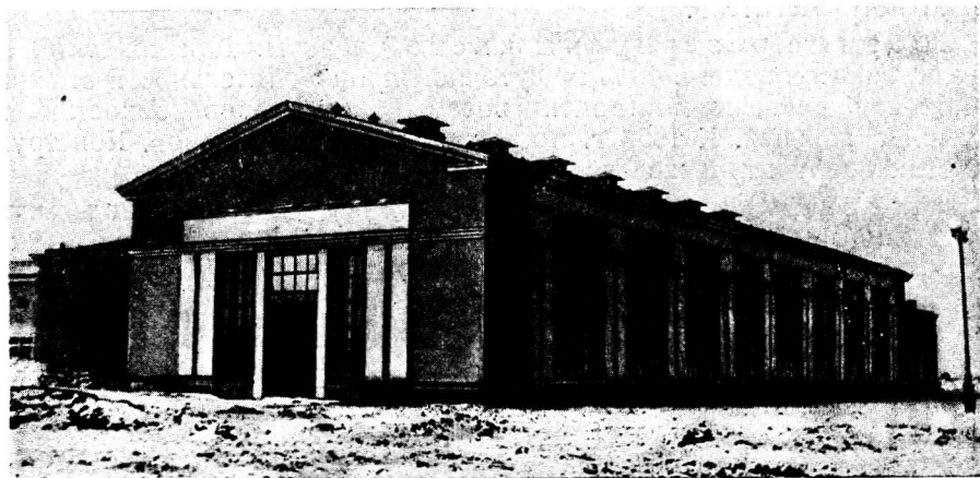
Фиг. 97. Машинное здание второго подъема.
