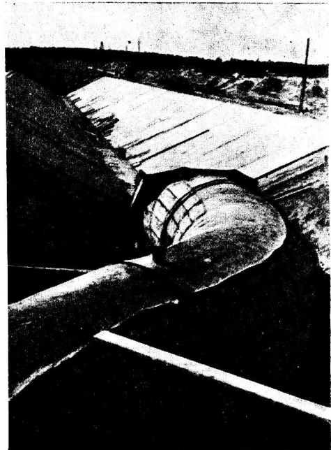
Фиг. 48. Сопряжение трубопровода с открытым каналом.
