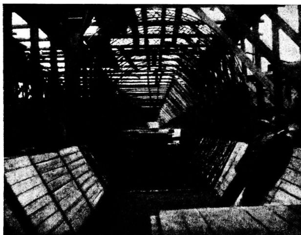
Фиг. 60. Установка арматуры трубопровода.
