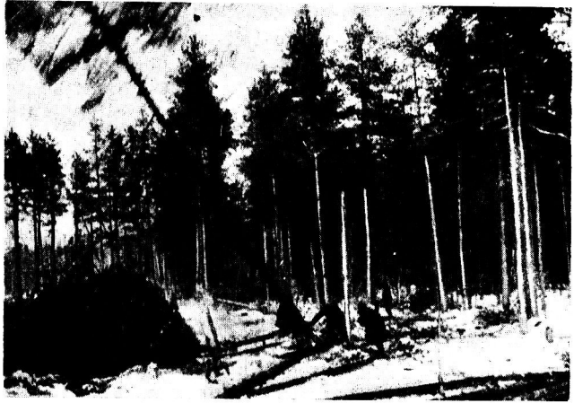
Фиг. 99. Вырубка леса на трассе Водопроводного канала.
