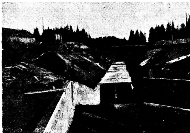
Фиг. 84. Вид ливневой трубы в постройке.
