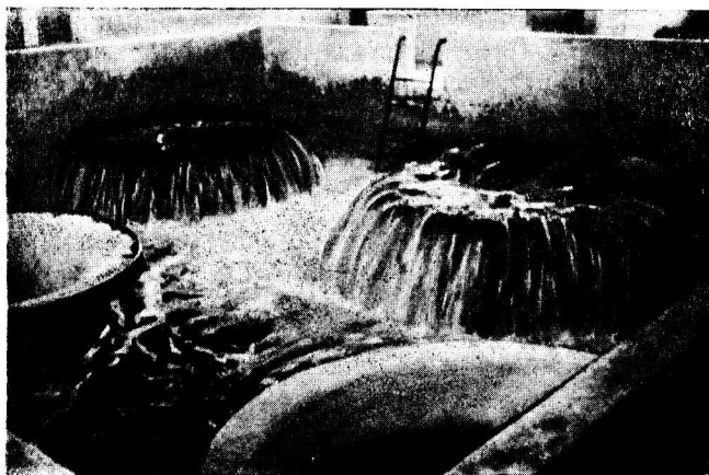
Фиг. 94. Воронки смесителя.
