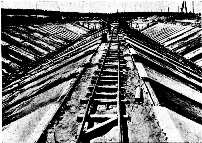
Фиг. 37. Бетонирование облицовки канала.
