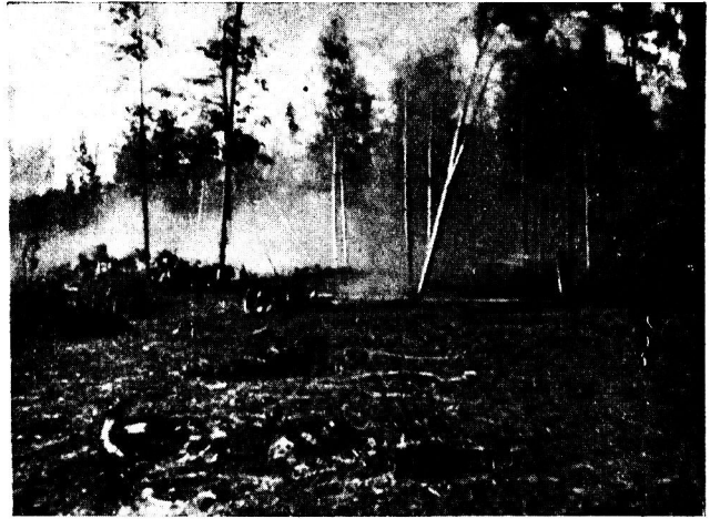
Фиг. 100. Очистка и сжигание хвороста и мусора на месте водохранилища.
