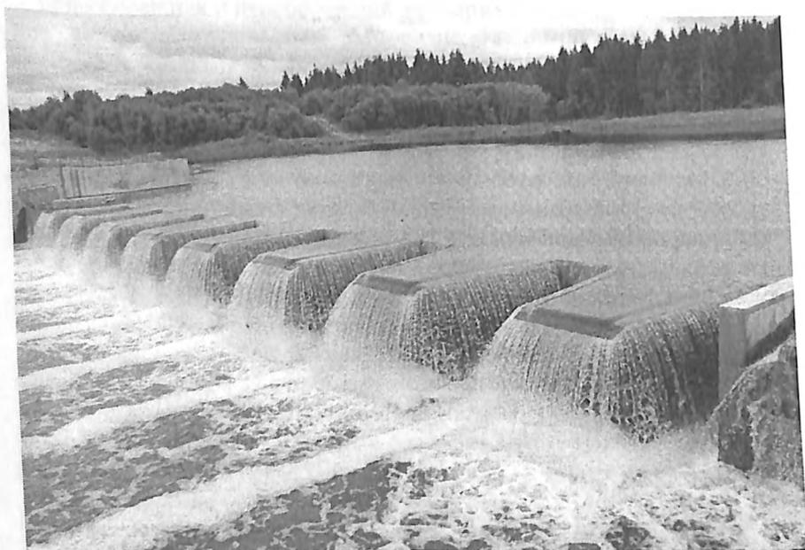
**Рис. 3.** Пропуск расхода через лабиринтный водосброс (3 июля 2003 г.)
