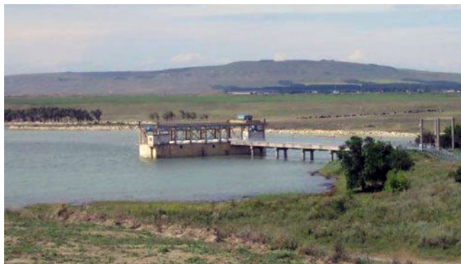
Рис. 1. Общий вид на здание существующей ГАЭС
